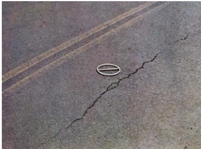
Figura 7: Trinca longitudinal.
