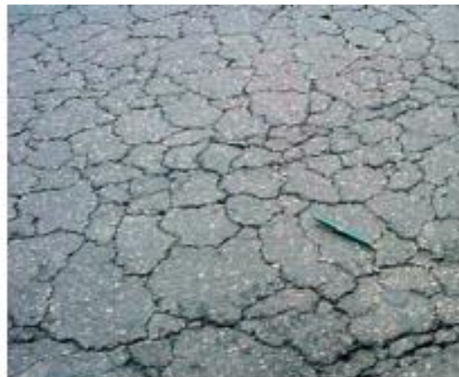
Figura 4: Ruptura por fadiga.
