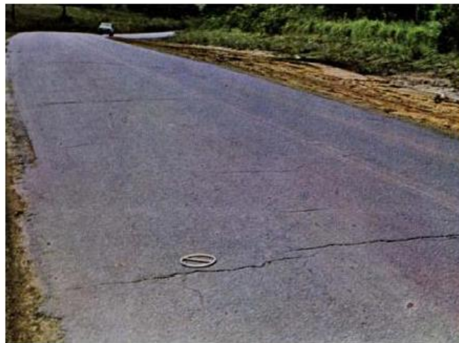
Figura 6: Trinca Transversal.
