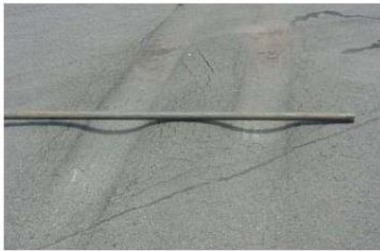
Figura 5: Exemplo de ruptura por deformação plástica em uma rodovia.
