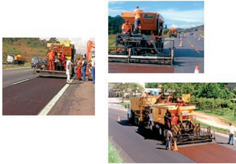
Figura 45: Aplicação micro revestimento.
