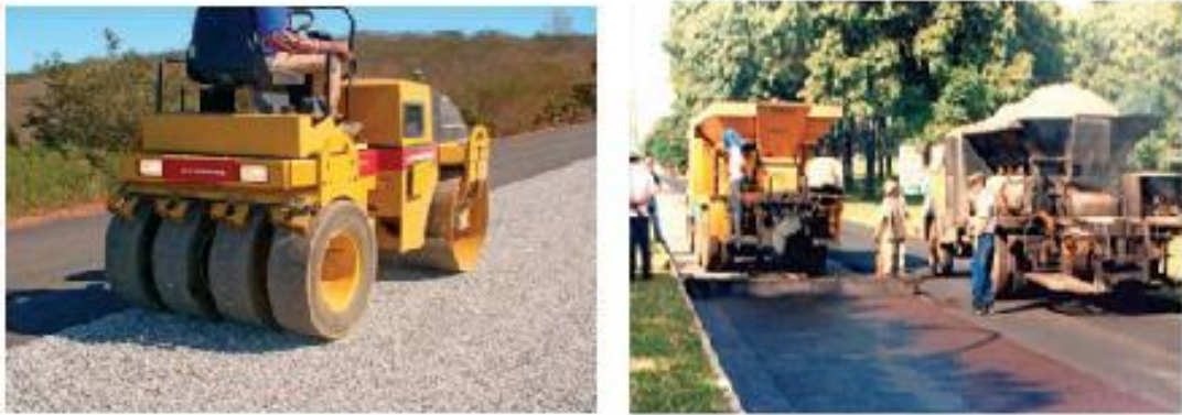
Figura 44: Compressão do agregado, aplicação de lama asfáltica.
