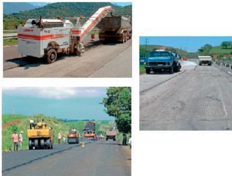
Figura 46: Fresagem, pós fresagem, recapeamento.
