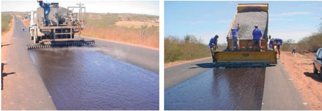
Figura 43: Aplicação de ligantes, distribuição de agregados.
