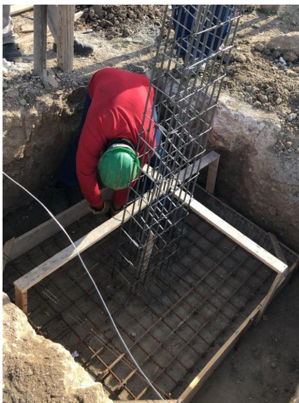
Figura 6 – Vista superior da sapata em execução
