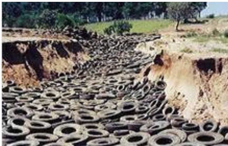
Figura 5: Pneus inteiros usados para contenção de erosão
