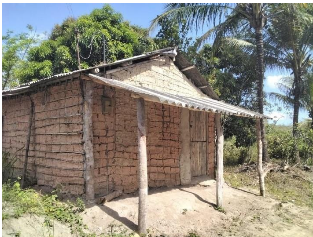
Figura 3 - Apresenta a construção em pau a pique
