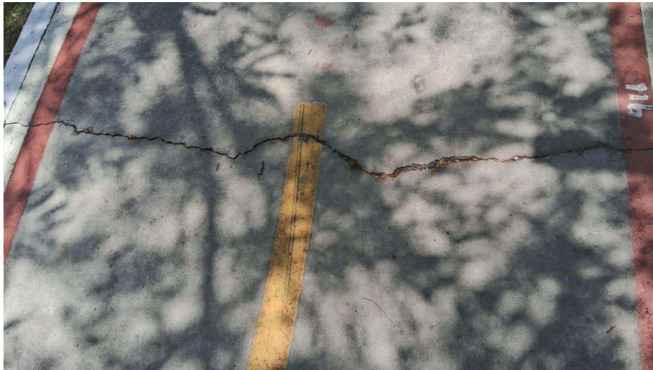
Figura 26 – Fissura transversal.
