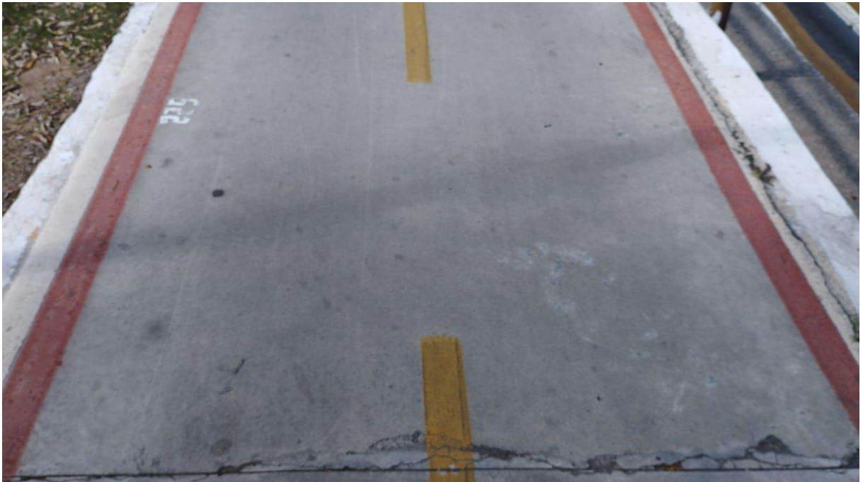
Figura 38 – Exposição da malha da armação.
