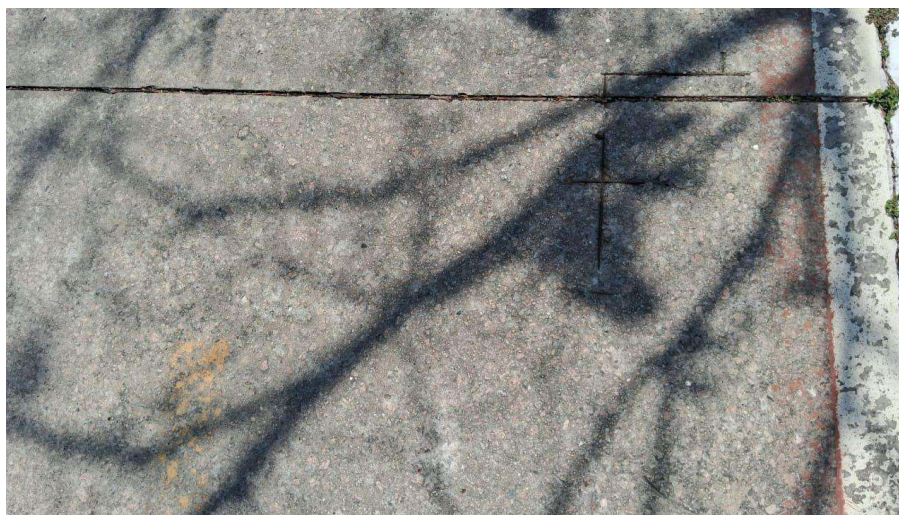
Figura 25 – Exposição da malha da armação.
