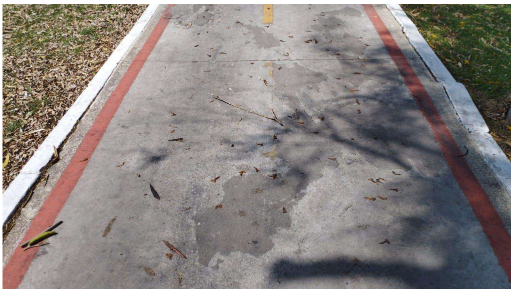
Figura 34 – Desgaste superficial e elevação do meio fio.
