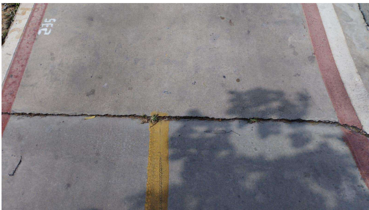
Figura 41 – Alçamento de placas com ruptura de canto.
