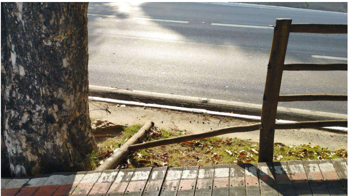
Figura 55 – Proteção da ciclovia quebrada.
