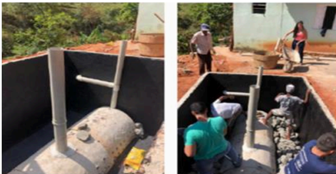
Figura 13 – Detalhe construtivo da câmara de digestão
