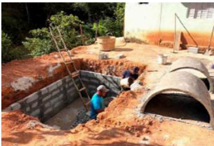
Figura 12 – Construção da BET em alvenaria
