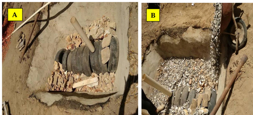
Figura 10 – Preenchimento do leito filtrante e detalhe da câmara digestora.
