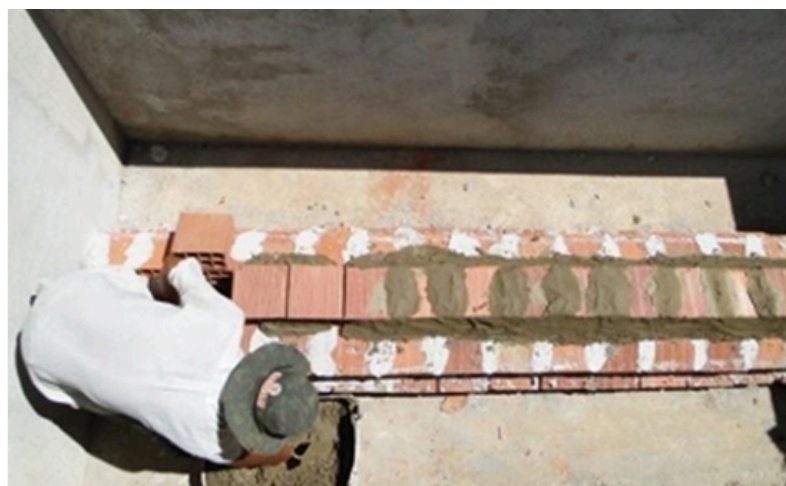
Figura 7 – Execução da câmara para digestão anaeróbia
