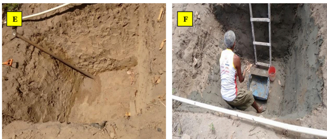
Figura 9 – Revestimento da vala escavada com cimento
