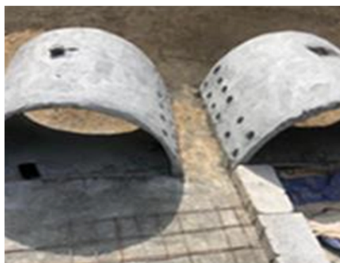
Figura 21 – Painéis de argamassa armada para construção da câmara de digestão anaeróbia
