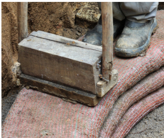
Figura 18 - Execução da técnica hiperadobe
