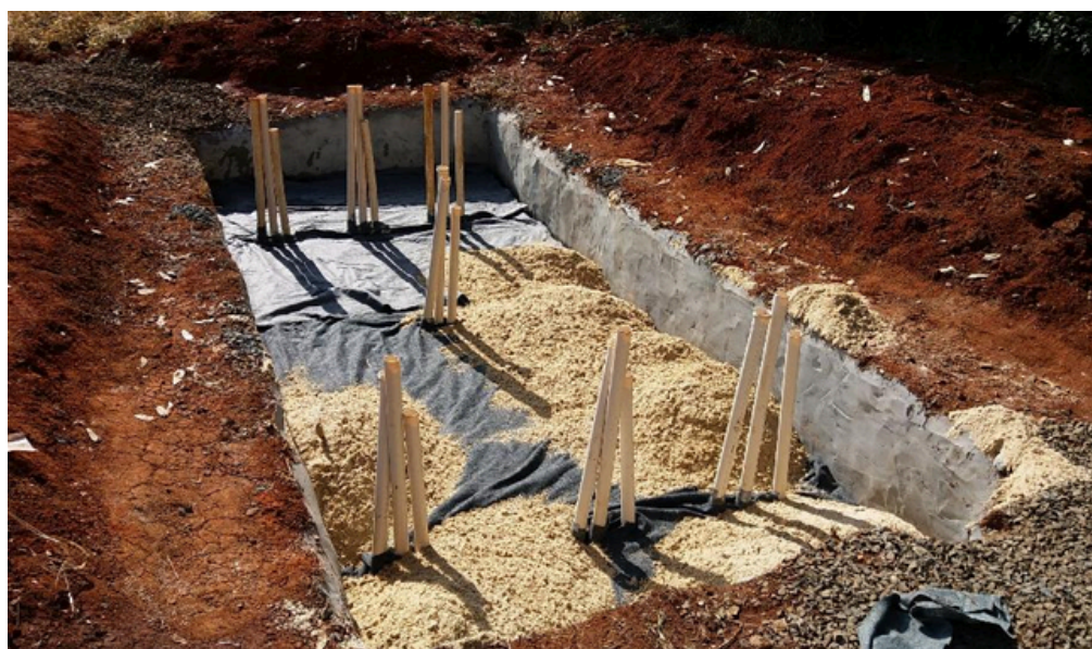
Figura 16 – Manta geotêxtil aplicada entre as camadas de brita e areia
