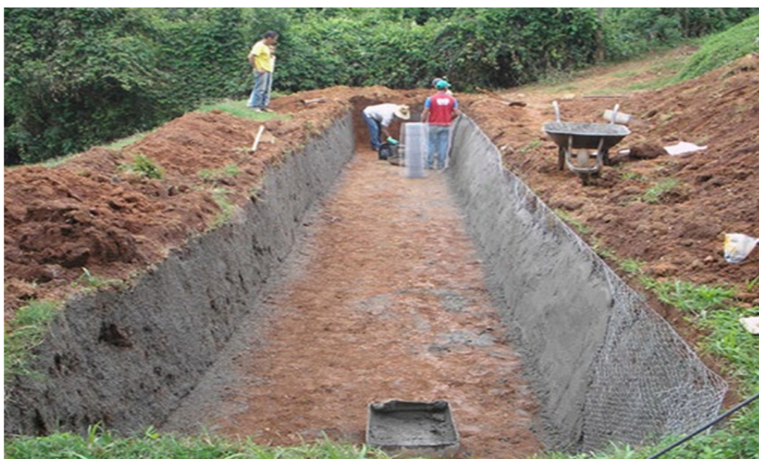
Figura 11 – Construção da BET com aplicação da técnica ferrocimento
