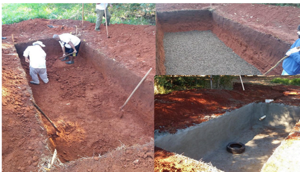
Figura 14 – Execução da bacia de evapotranspiração
