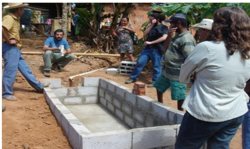
Figura 6 – Oficina para a construção da bacia de evapotranspiração
