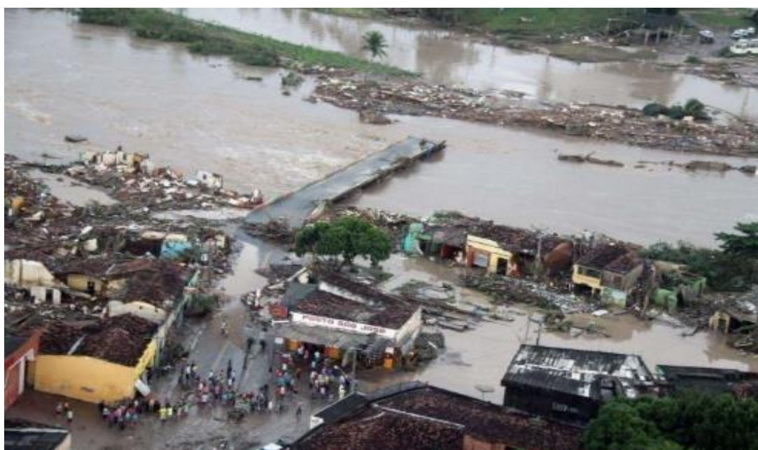
Figura 2 – Danos causados pela enchente de 2010 em União dos Palmares
