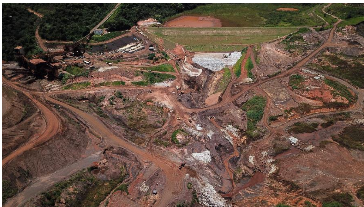
Figura 6 - Vista aérea da destruição causada pelo rompimento da barragem da Vale, em Brumadinho
