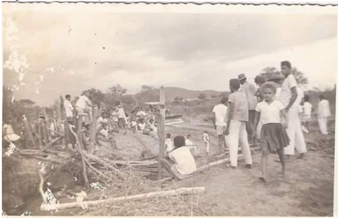
Imagem 06 – Foto da destruição da lavanderia coletiva.
