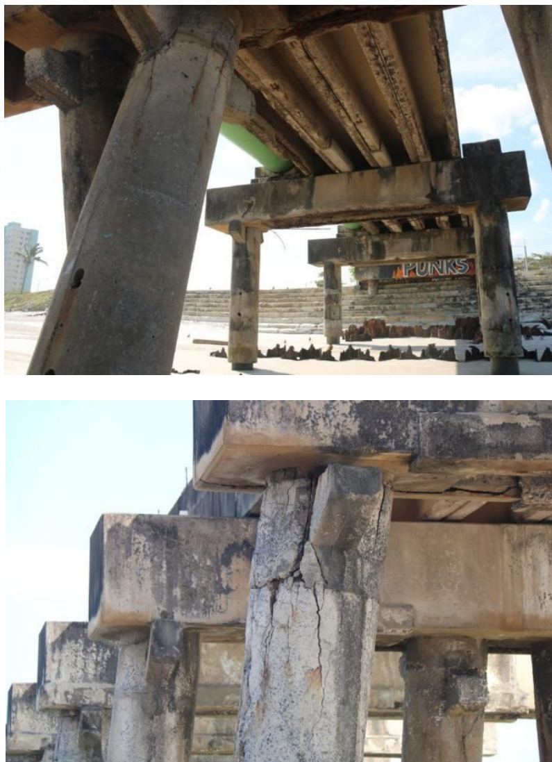
Figura 4 - Vistoria no Emissário Submarino de Maceió
