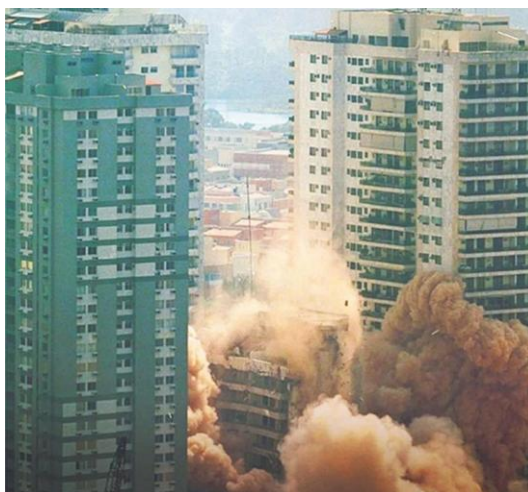
Figura 7 – Demolição do Edifício Palace II
