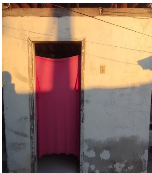
(c) aplicação de gesso nas fissuras e trincas
