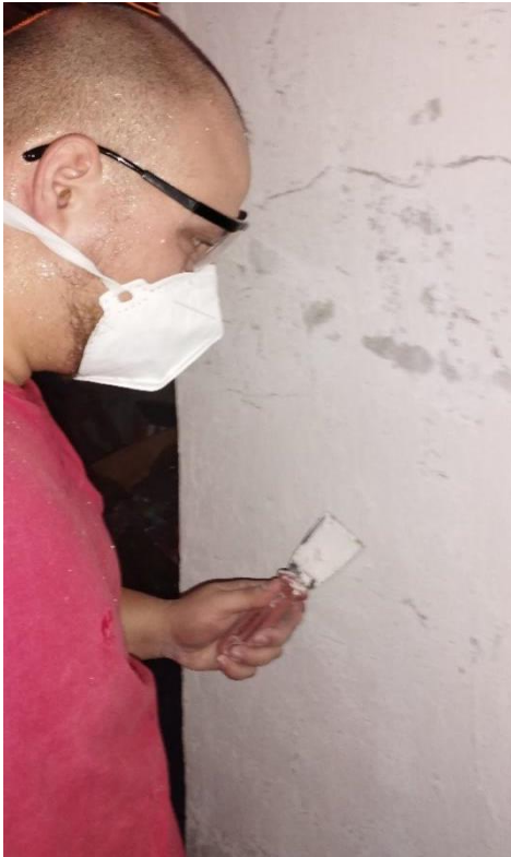
(a) remoção de imperfeições com espátula
