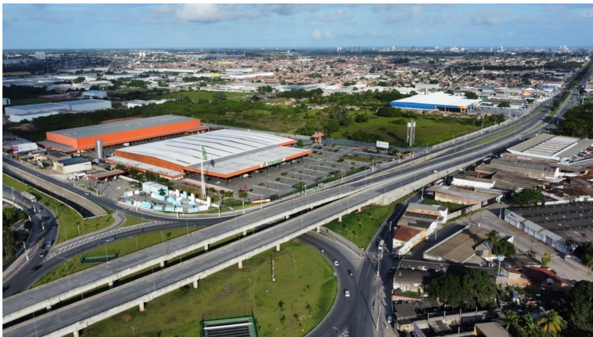
Figura 13 – Redes varejistas instaladas no entroncamento rodoviário das BRs 316 e 104, em Maceió
