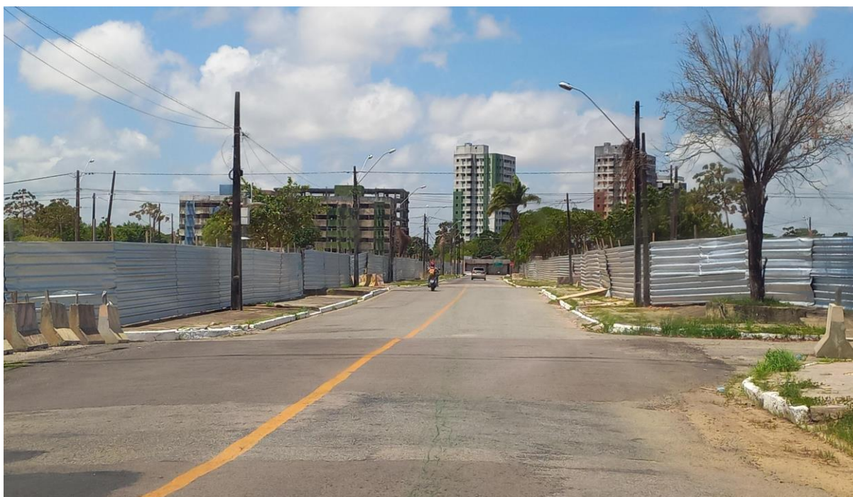
Figura 8 – Rua Dr. Jovino Lopes Lyra, no Pinheiro, após demolição de imóveis afetados pela subsidência do solo
