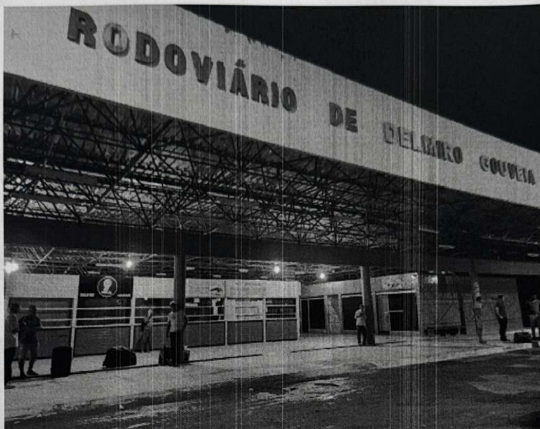
Figura 6 - Terminal rodoviário de Delmiro Gouveia – AL, ponto de embarque de transporte coletivo regulamentado
