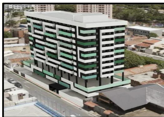
Figura 31: Modelagem de 3D do edifício E Fonte: Google Maps, 2023
