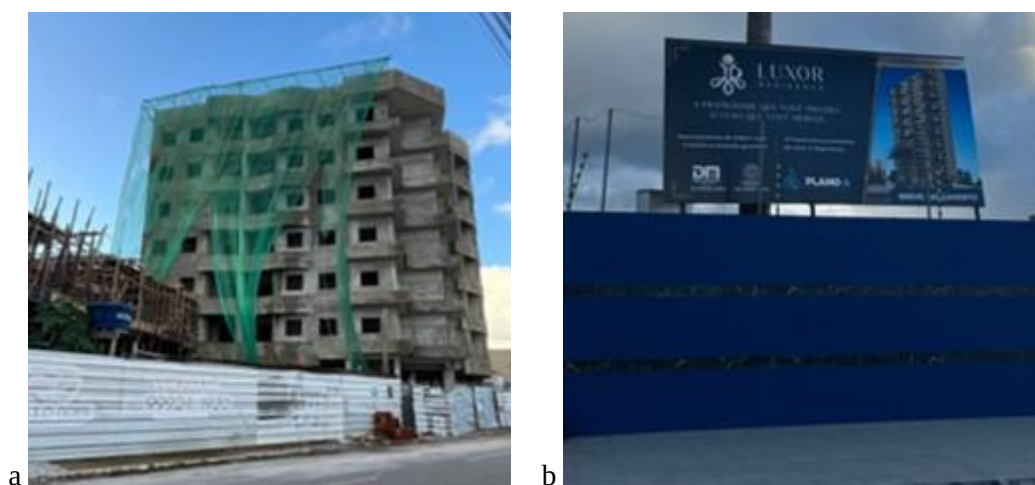
Figura 35 – Edifícios em processo de construção (a) e em processo de lançamento (b).
