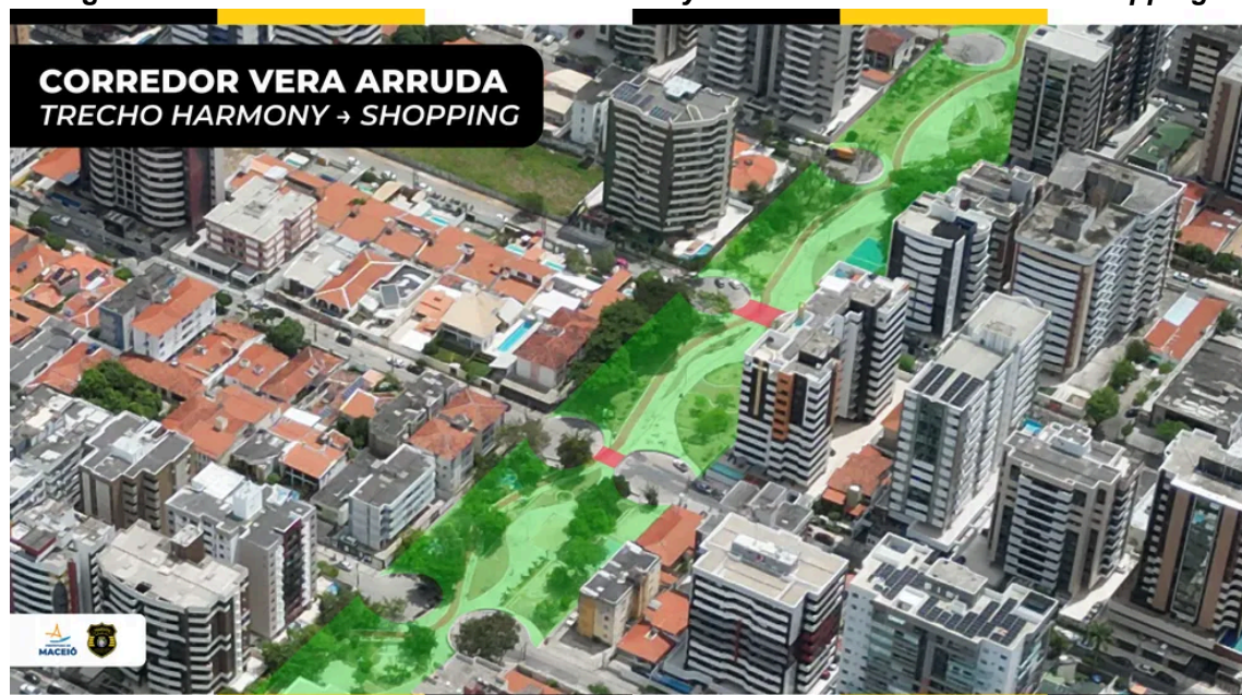
Figura 49 – Abertura entre o Edifício Harmony Medical Center e o Maceió shopping
