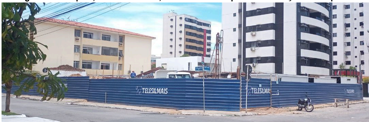
Figura 76 – Depois, Janeiro de 2025, imóvel demolido para a construção de um prédio
