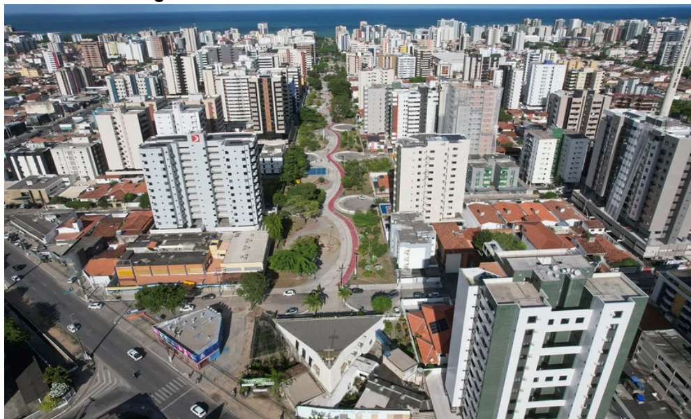
Figura 47 – Vista Aérea do Corredor Vera Arruda
