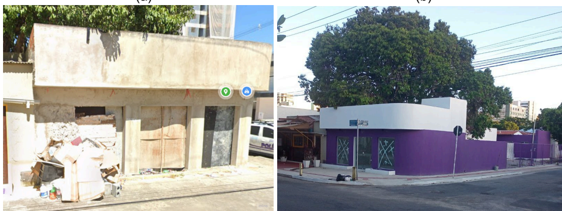
Figura 74 – (a) Antes, Julho de 2024 e (b) depois Janeiro de 2025, respectivamente
