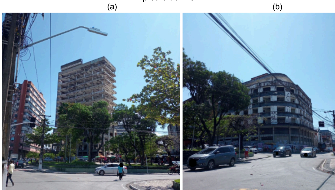
Figura 26– Prédios abandonados no bairro do Centro, (a) o edifício Palmares e (b) o antigo prédio do IBGE
