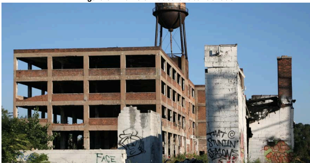
Figura 3 – Edifício industrial abandonado.
