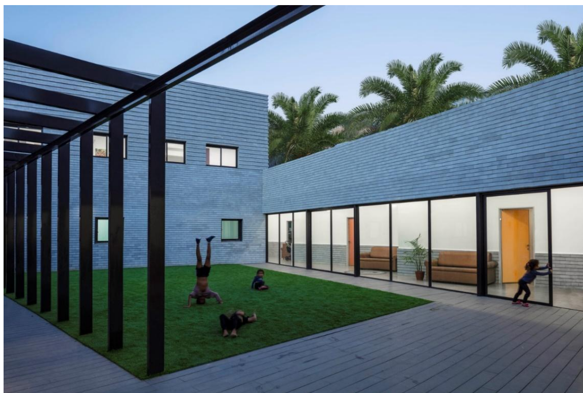
Figura 13: Vista para o jardim interno.
