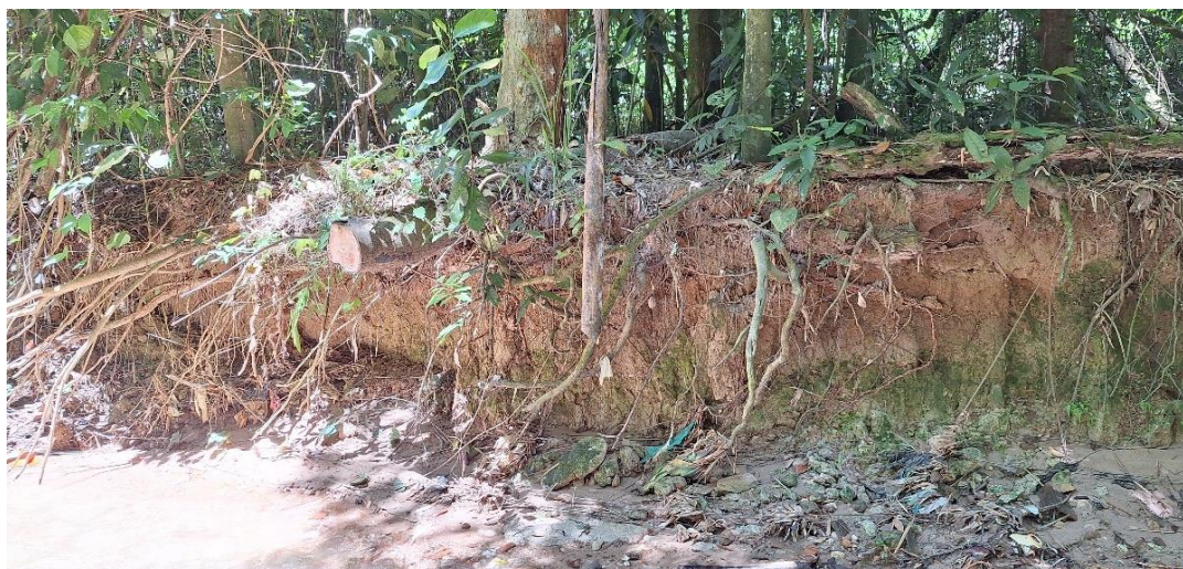
Figura 21 - Destruição da área de preservação permanente devido as vazões de pico.
