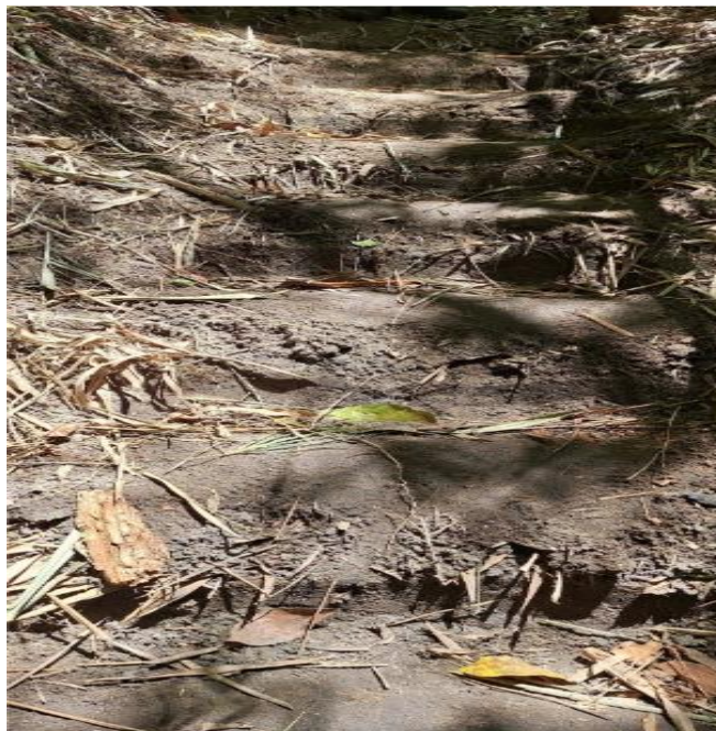
Figura 56 - Falta de manutenção periódica, escada feita de terra, ocasionando risco de possíveis acidentes.
