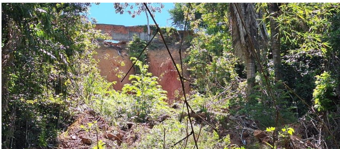
Figura 26 - Erosão Meia Encosta dentro do parque municipal oriunda do escoamento superficial de áreas urbanas.
