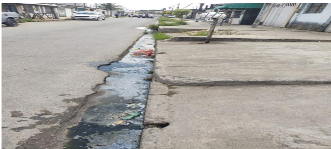
Figura 35 - Lixo no esgoto à céu aberto
