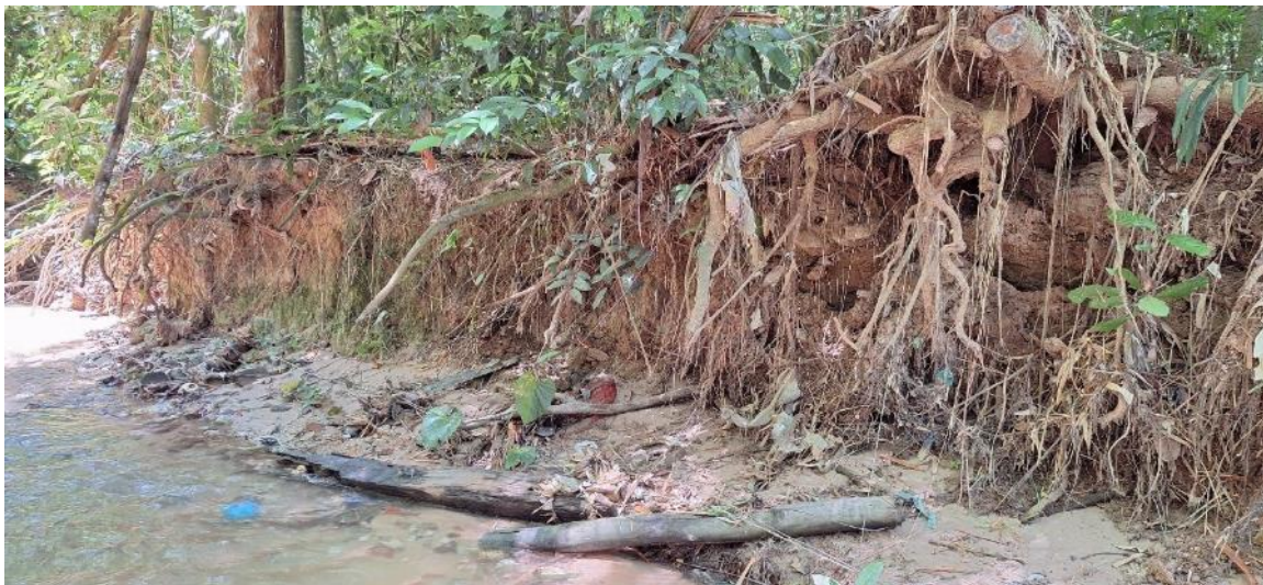
Figura 29 - Erosão Fluvial no Parque - Raízes Expostas de Árvores.
