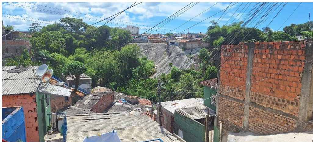
Figura 19 - Urbanização Desordenada em Área Declivosa
