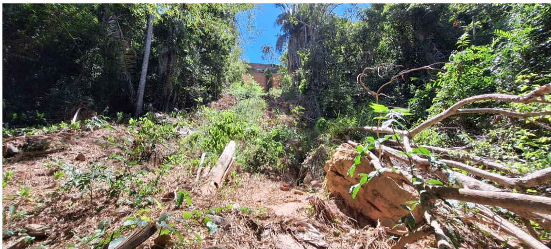
Figura 27 - Visão Ampla do Impacto da Erosão Meia Encosta.
