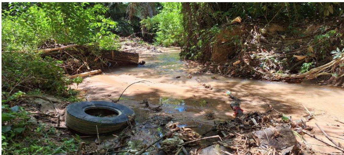
Figura 23 - Assoreamento no Riacho do Silva no interior do Parque com sedimentos e lixo.
