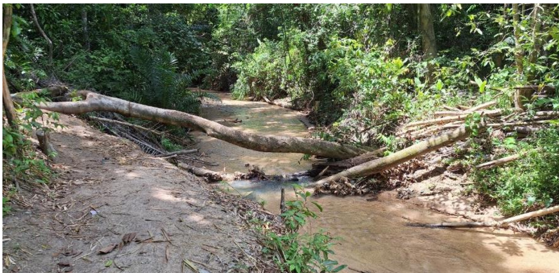
Figura 48. Margem do rio comprometida, queda de árvore e redução da proteção natural dos cursos d'água - No Parque.
