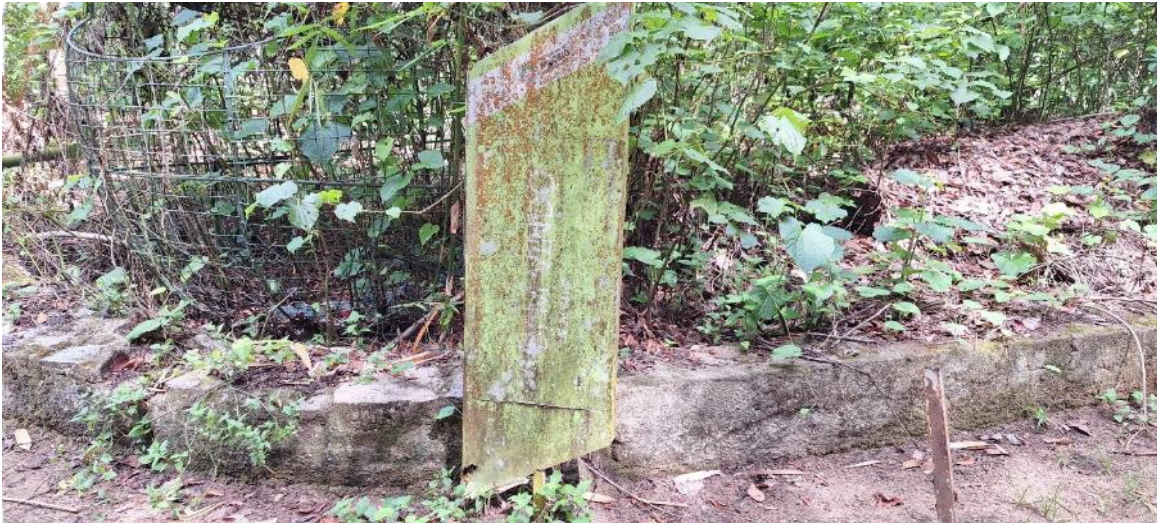
Figura 53 - Placas de sinalização deterioradas com linguagem pouco acessível
