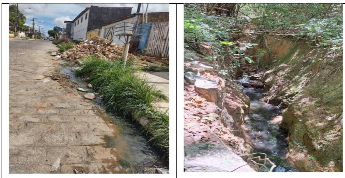
Figura 9 - Esgoto à céu aberto fora do parque e esgoto a céu aberto dentro do Parque.
