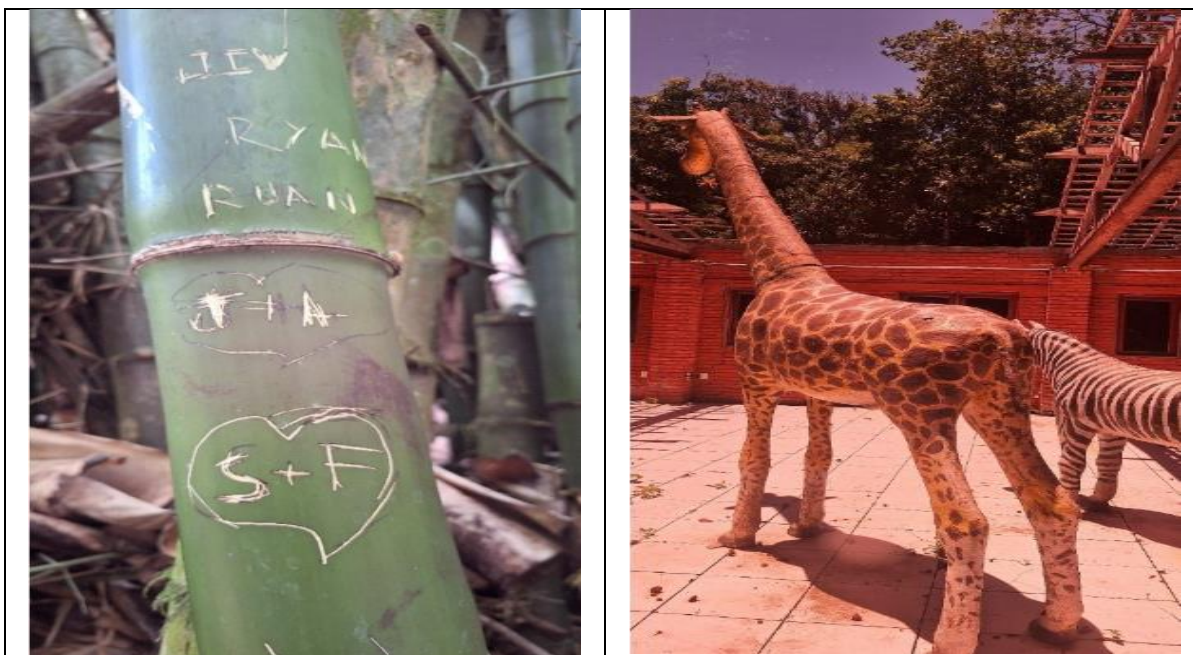
Figura 66 - Falta de educação ambiental (riscos estruturais no bambu) e falta de manutenção da infraestrutura do Parque.
