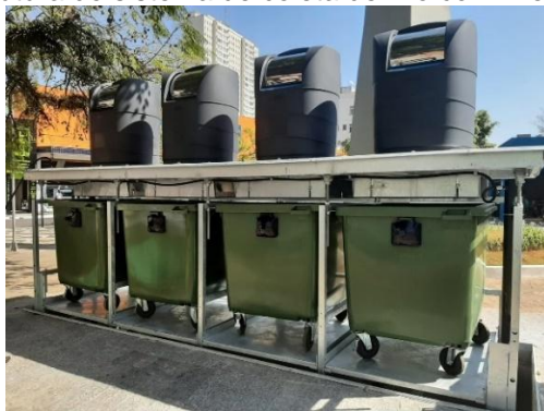
Figura 37 — Estrutura do sistema de coleta de lixo com lixeiras subterrâneas.
