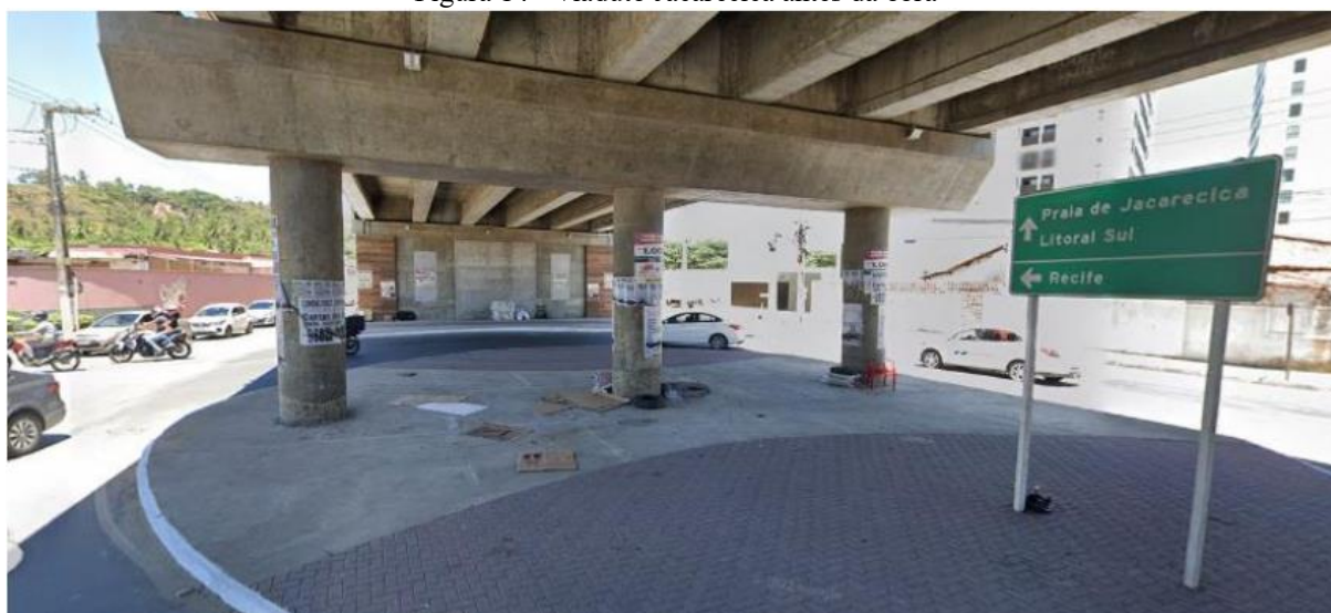
Figura 14 - Viaduto Jacarecica antes da obra
