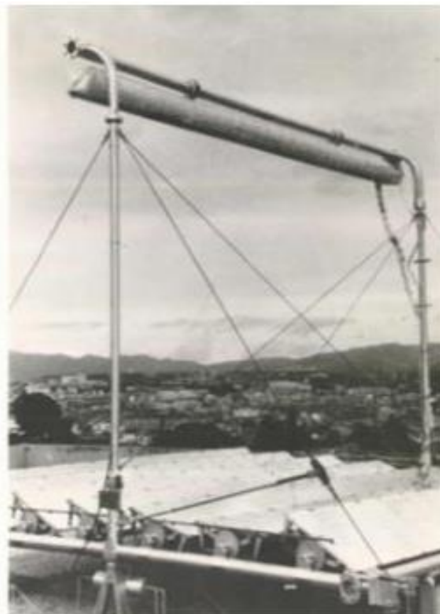
Figura 11 – Primeiro protótipo de coletor linear Fresnel
