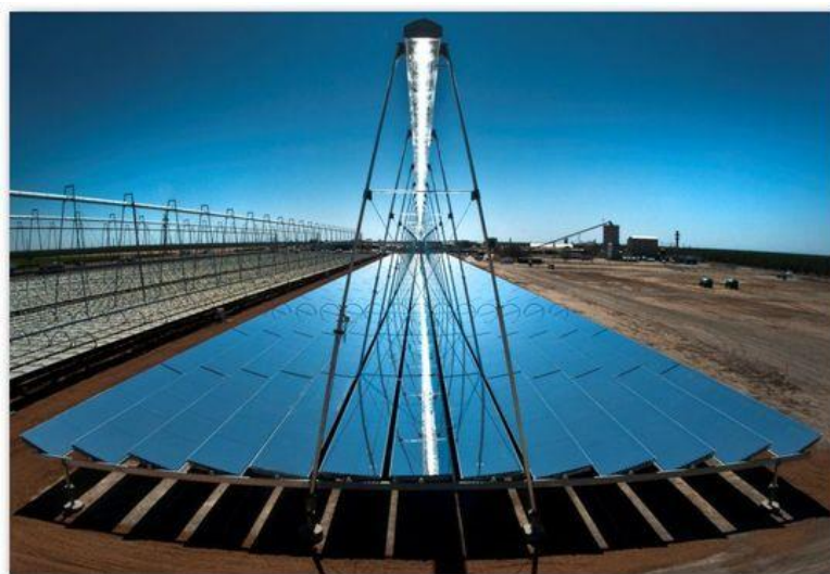
Figura 13 – Esquema de concentrador solar Fresnel Linear
