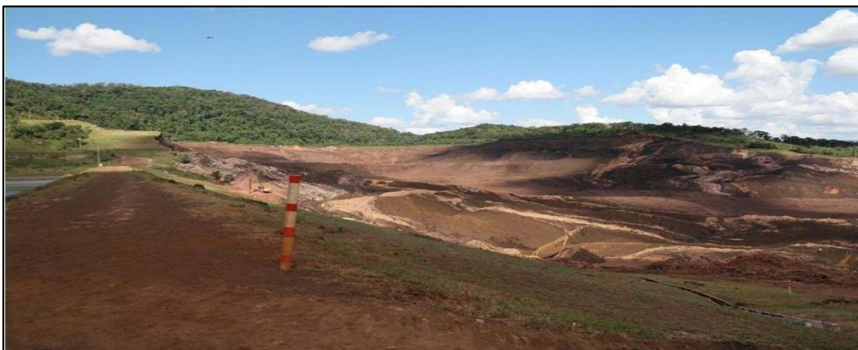
Figura 12 - Barragem B I após o rompimento e a parte da ombreira direita da barragem
