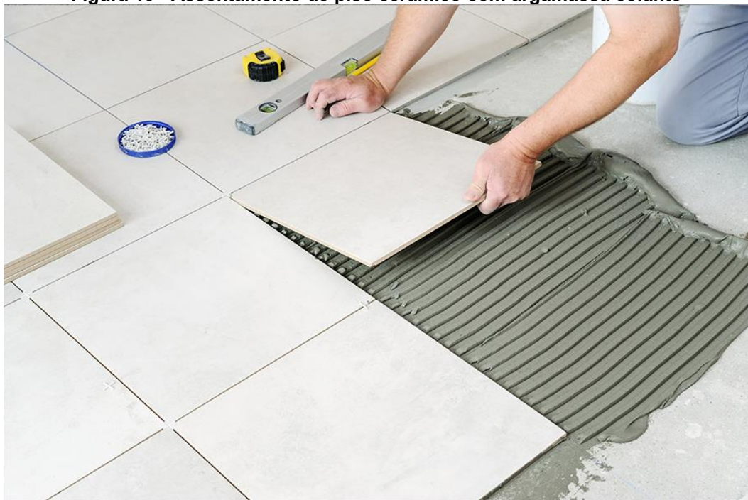
Figura 19 - Assentamento de piso cerâmico com argamassa colante
