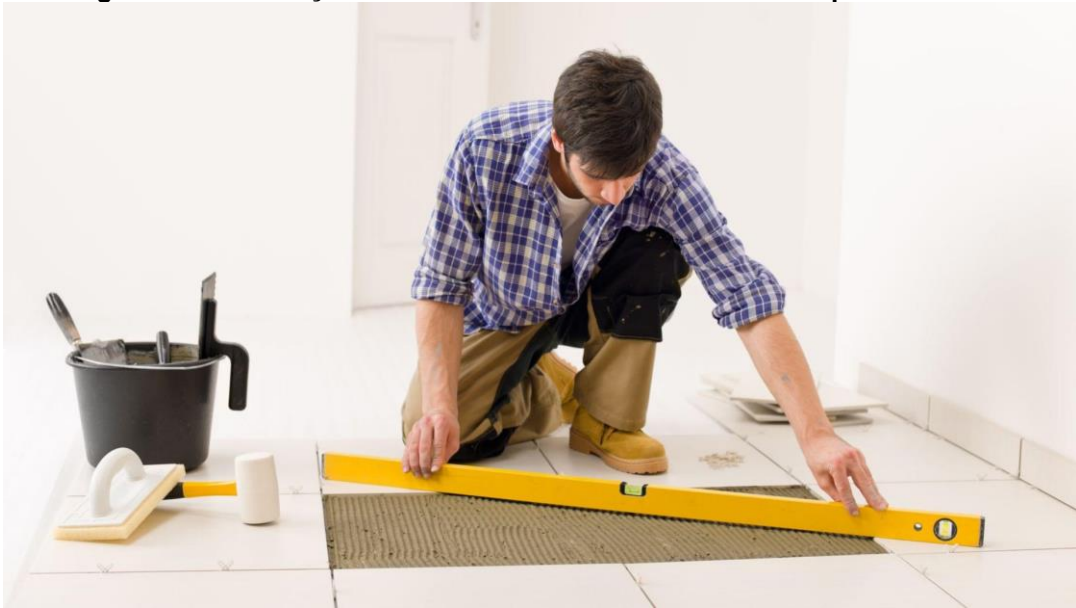
Figura 20 - Verificação do nivelamento no assentamento de piso cerâmico
