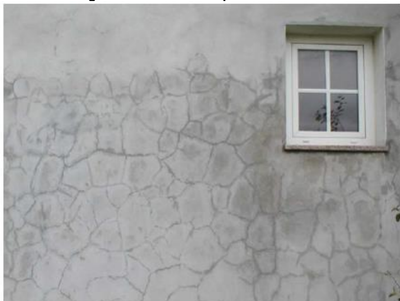
Figura 7 - Fissuras em parede rebocada
