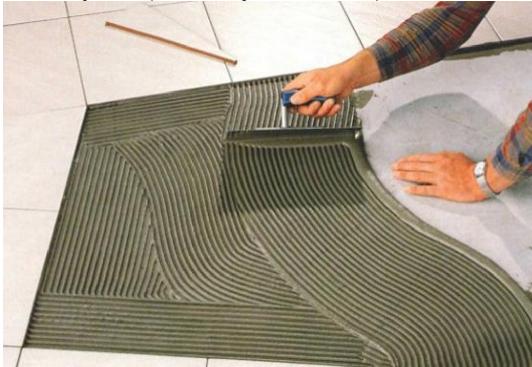
Figura 18 - Aplicação de argamassa colante em piso cerâmico
