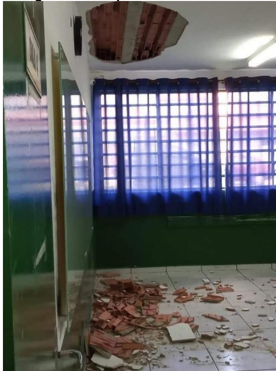
Figura 10 - Desprendimento de reboco
