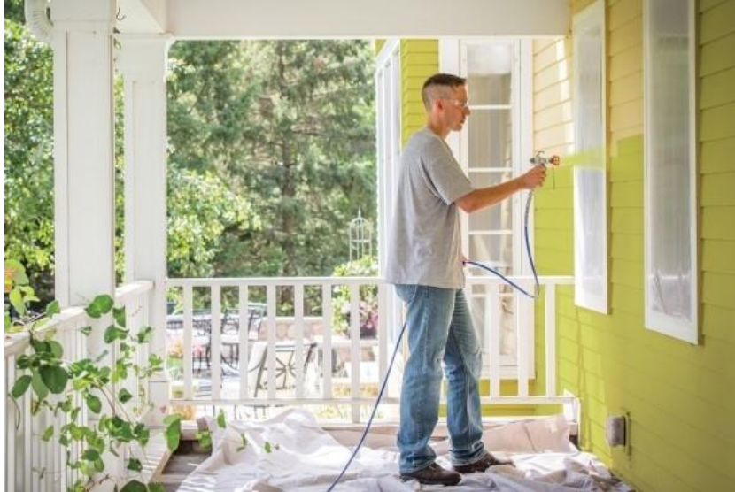
Figura 29 - Pintura de fachada externa utilizando pulverizador de tinta
