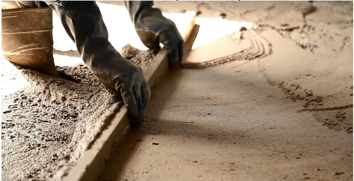
Figura 11 - Nivelamento de contrapiso com desempenadeira manual
