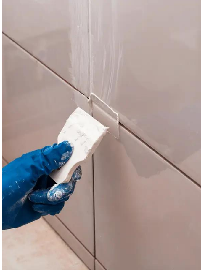
Figura 15 - Aplicação de rejunte acrílico em revestimento cerâmico
