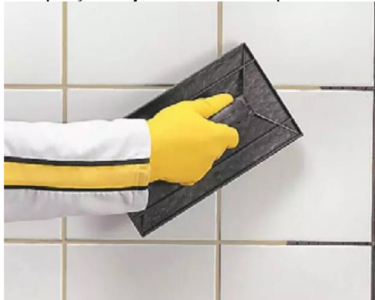
Figura 16 - Aplicação de rejunte utilizando desempenadeira de borracha
