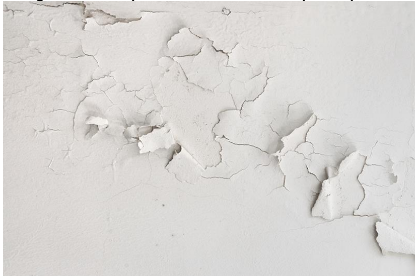
Figura 30 - Exemplo de descascamento em parede pintada
