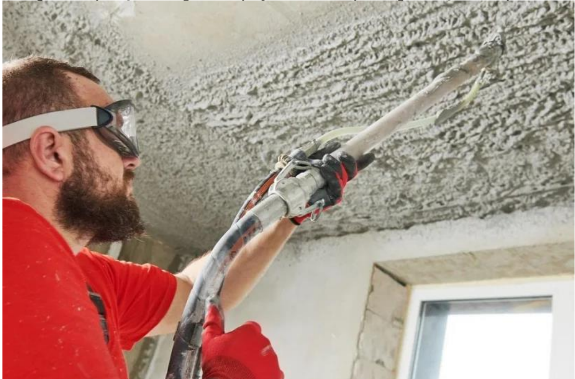
Figura 9 - Aplicação de argamassa projetada em teto para regularização de superfície
