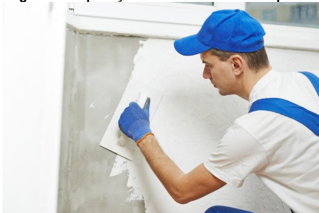
Figura 23 - Aplicação de massa corrida em parede
