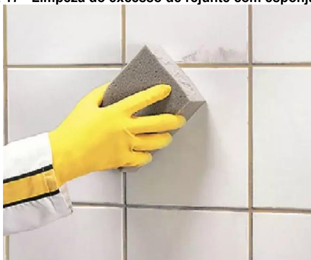
Figura 17 - Limpeza do excesso de rejunte com esponja úmida
