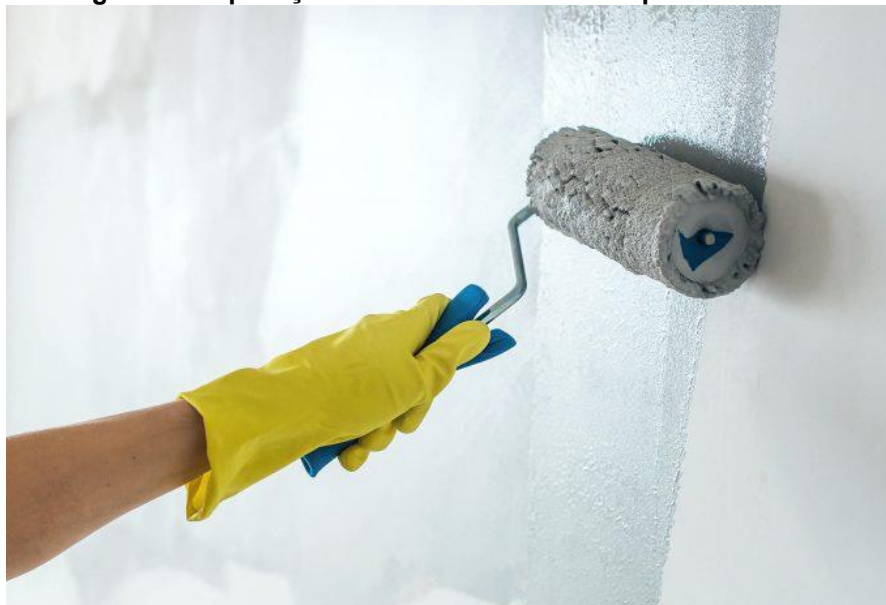
Figura 28 - Aplicação de tinta com rolo em superfície interna
