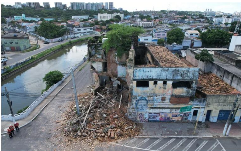
Figura 02 – Parte da demolição do Hotel Atlântico em 23 de abril de 2024
