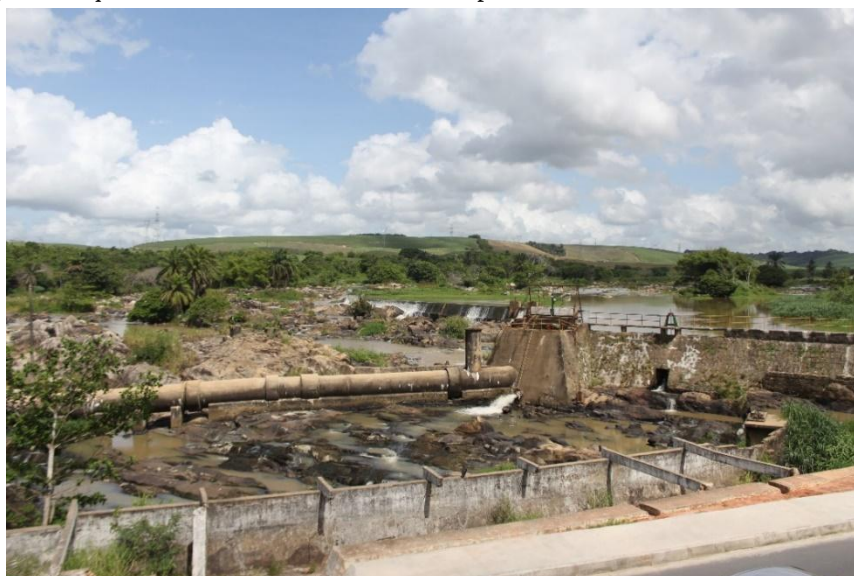
Fig. 07 – Aqueduto construído na década de 50 pela construtora Odebrecht , Rio Largo - AL
