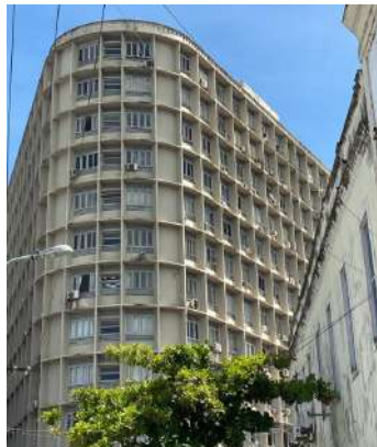
Figura 01 - Edifício Brêda, localizado no Centro de Maceió e construído em 1958.
