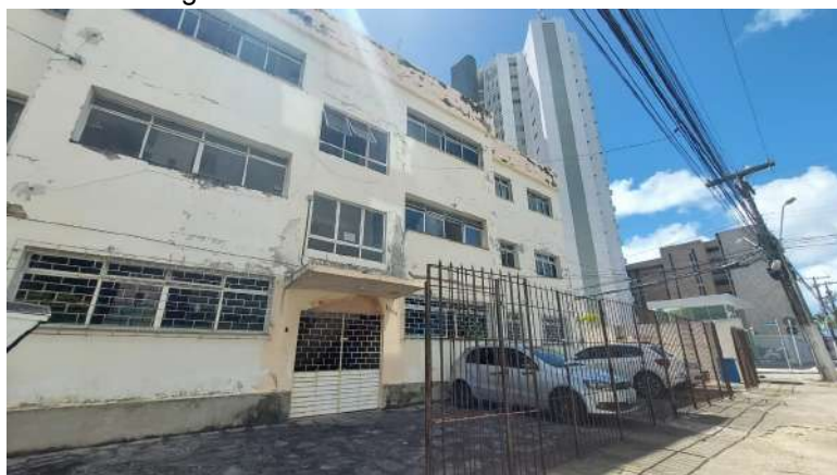
Figura 27 - Edifício Ponta Verde em 2024.
