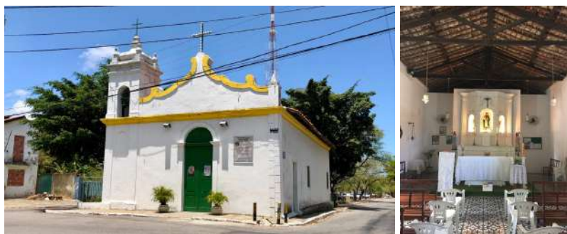
Figura 39: Imagem A e B com a fachada e foto da área interna da Capela São Gonçalo.
