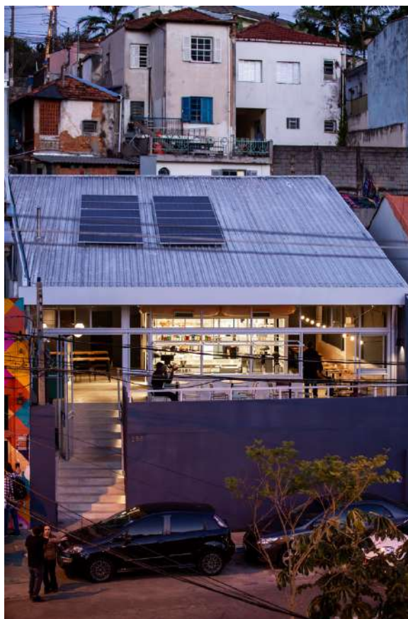
Figura 10: Exterior Restaurante Corrutela.
