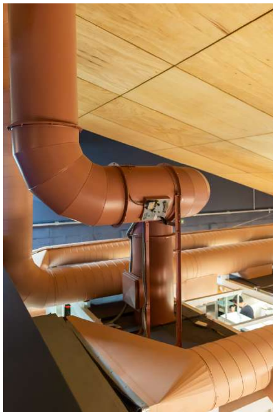
Figura 12: Vista da Coberta.
