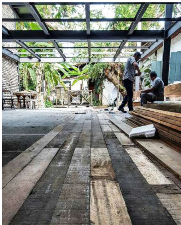
Figura 23: Etapa da Obra - Estrutura metálica e madeiramento reaproveitado.
