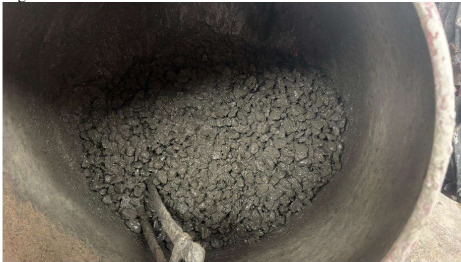
Figura 15: Processo de mistura dos materiais na betoneira
