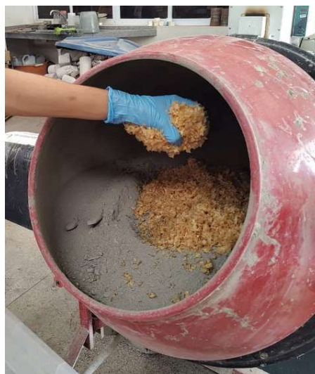
Figura 33 – Mistura da areia, cimento e serragem no preparo do traço 6. a) Mistura do cimento e areia até homogeneização e b) Adição da serragem.
