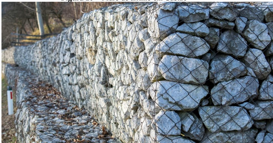
Figura 20 - Muro de arrimo em Gabião
