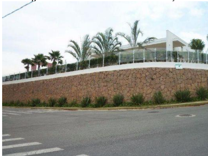
Figura 18 – Muro de arrimo de Pedra com rejunte
