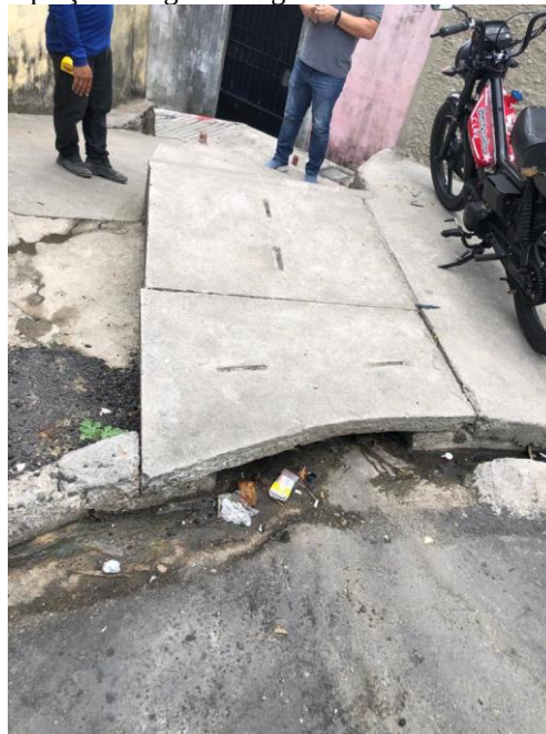
Figura 37 - Captação de águas e esgoto vindo do Bairro Feitosa
