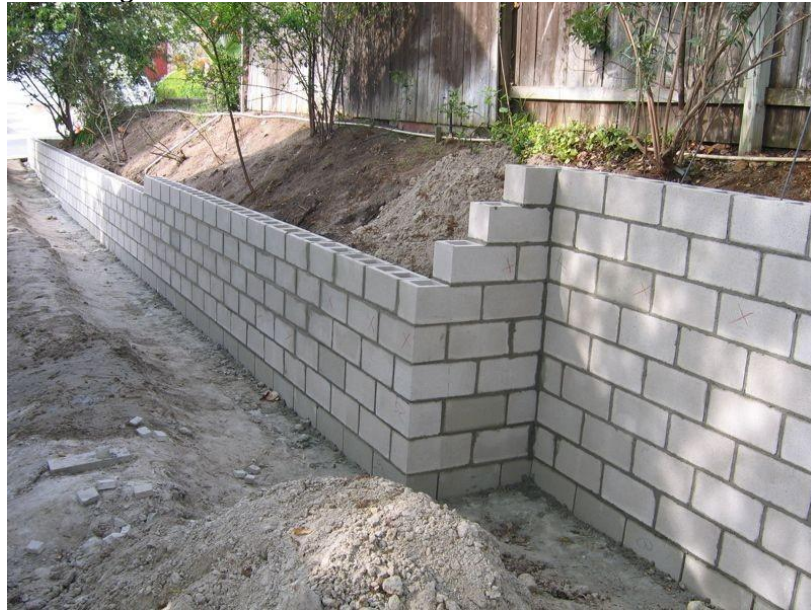
Figura 19 - Muro de arrimo em bloco de concreto
