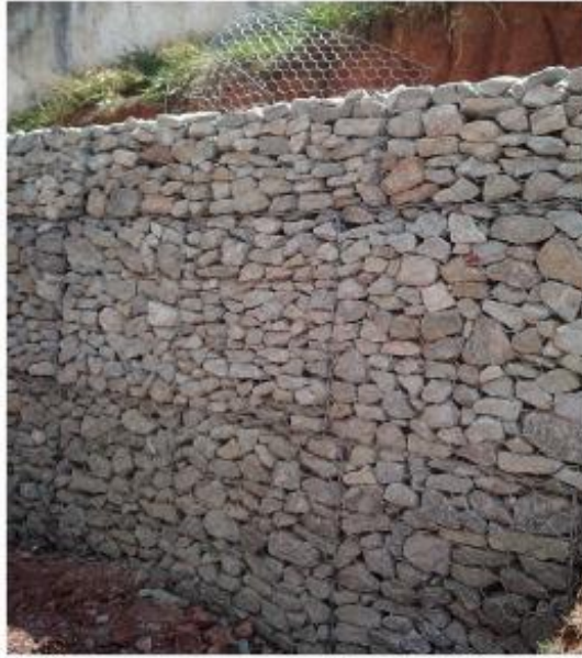
Figura 17 - Muro de arrimo em Gabião
