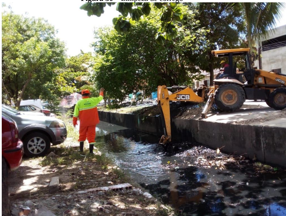
Figura 30 – Limpeza de córrego
