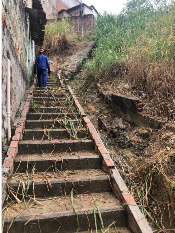
Figura 41 - Escadaria em construção com sistema de drenagem na lateral.
