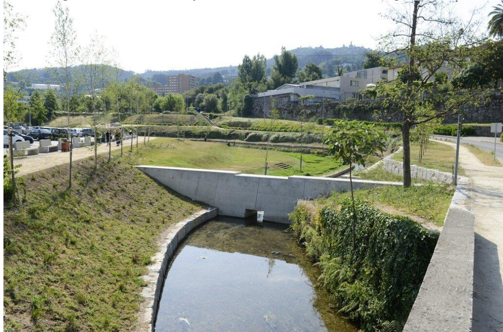
Figura 9 – Bacia de Retenção da cidade de Guimarães, em Portugal
