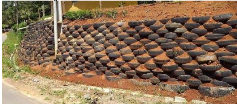
Figura 21 – Muro de arrimo com pneu
