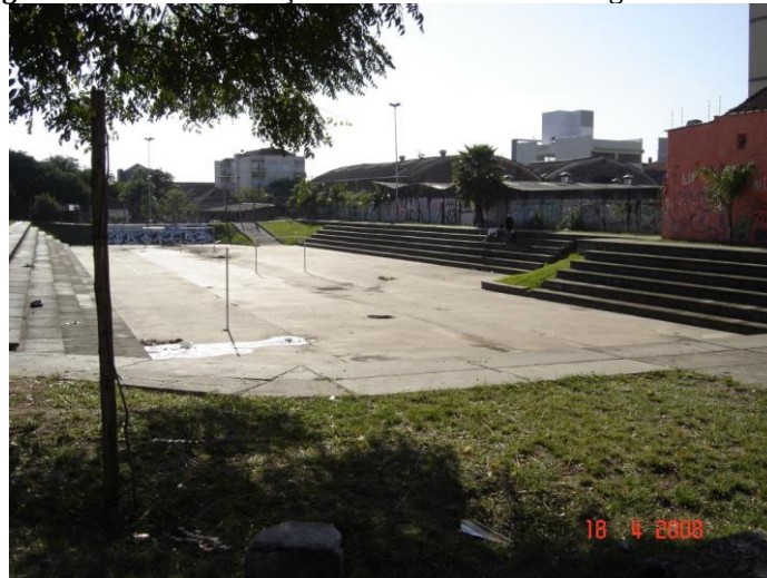
Figura 8- Bacia de Detenção da Cidade de Porto Alegre - RS
