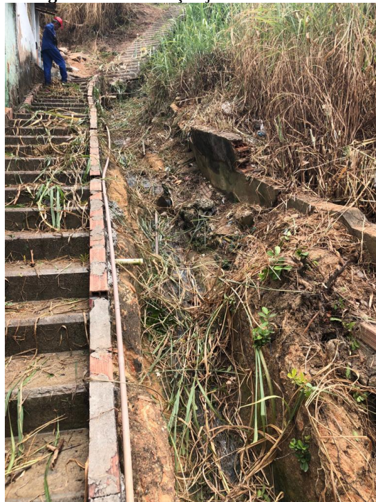
Figura 42 - Escavação já existente
