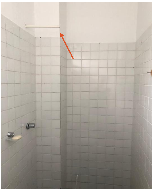
Figura 48 - Banheiro da sala da nutricionista
