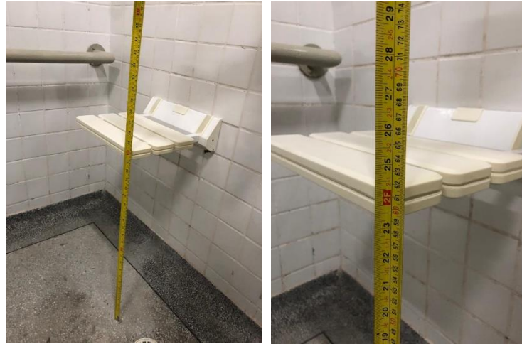
Figura 45 - Banco de banho da cabine acessível do banheiro masculino
