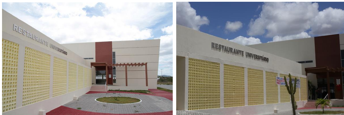
Figura 8 - Estado de conservação da fachada antes do início das operações
