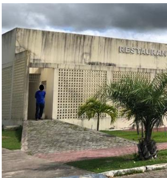
Figura 14 - Rampa de acesso a funcionários
