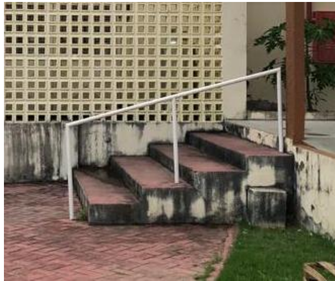
Figura 10 - Escada de acesso principal ao RU
