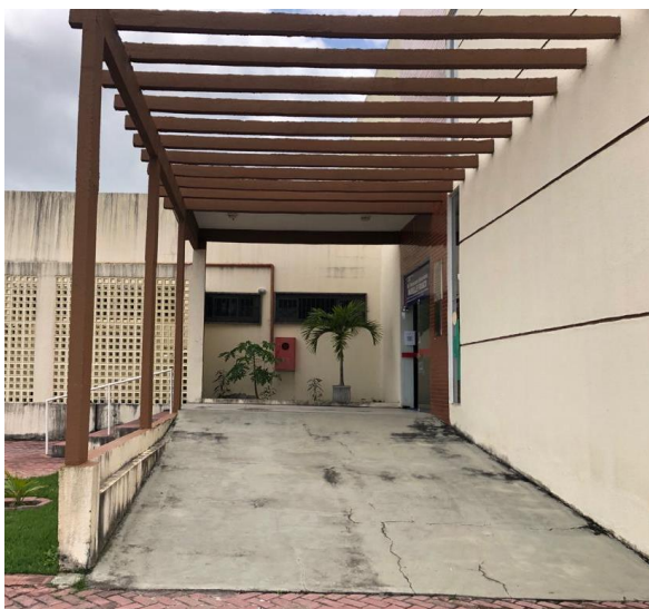
Figura 13 - Rampa de acesso principal
