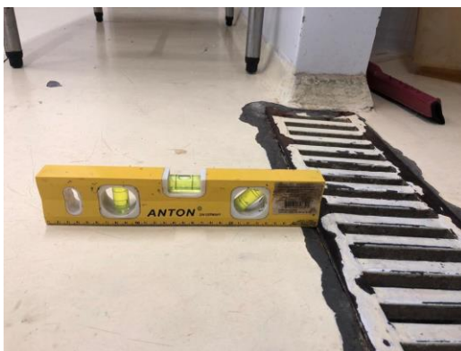
Figura 34 - Aferição da inclinação do piso em direção as grelhas
