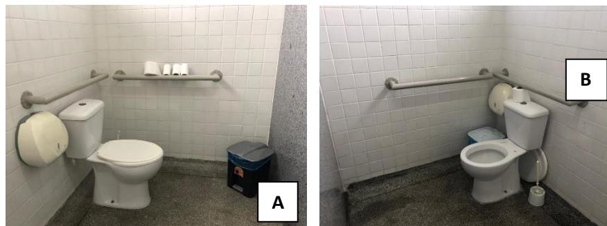
Figura 25 - - Disposição das barras e acessórios das cabines acessíveis do reservado feminino (A) e do reservado masculino (B)
