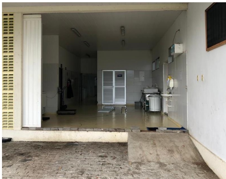
Figura 17 - Rampa de acesso a mercadorias
