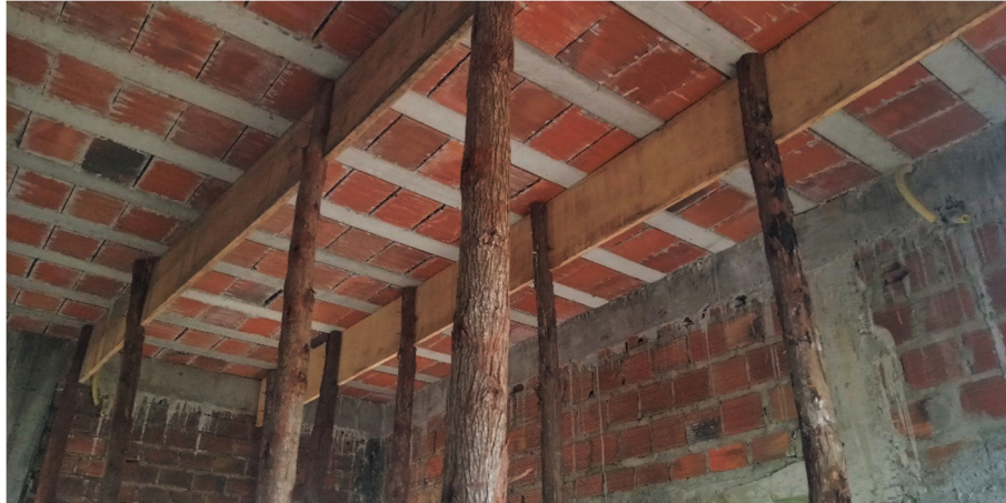
Figura 26: Escoramento para sistema de laje treliçada
