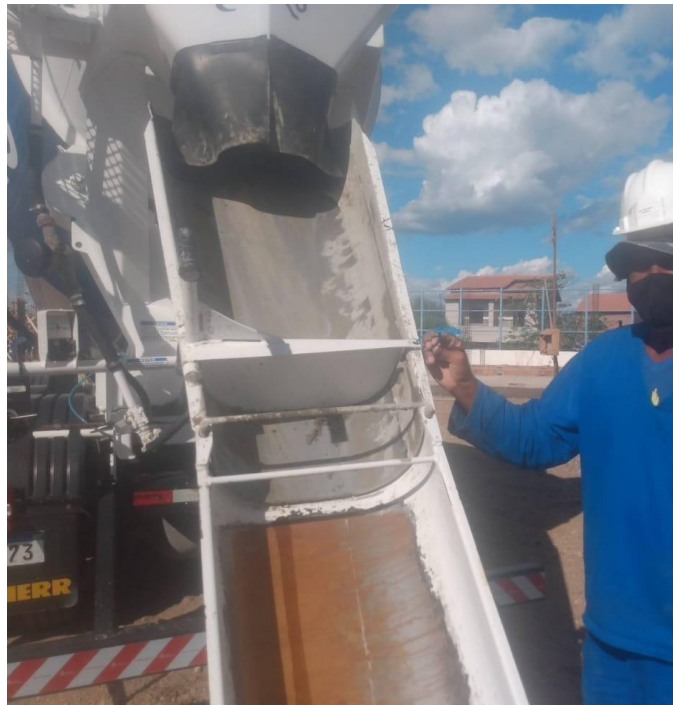
Figura 16- Recebimento do concreto usinado
