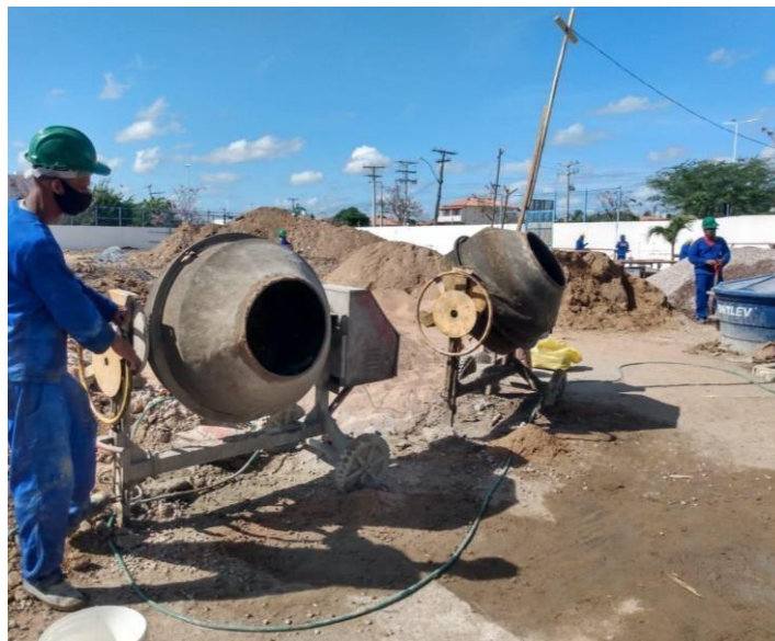
Figura 9- Betoneira; central de material e Caixa d'água para armazenamento da água.
