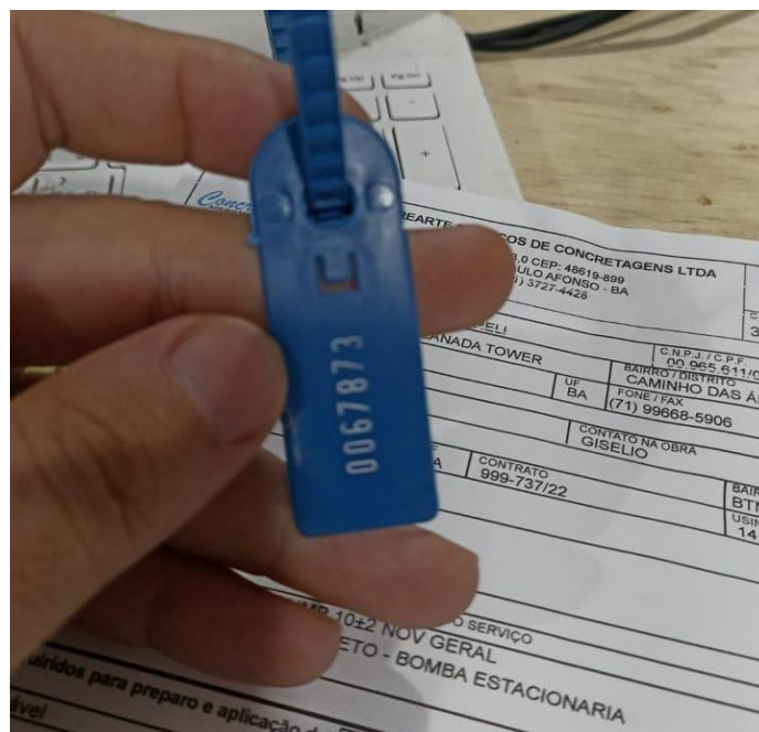
Figura 17-Conferência do lacre da betoneira.
