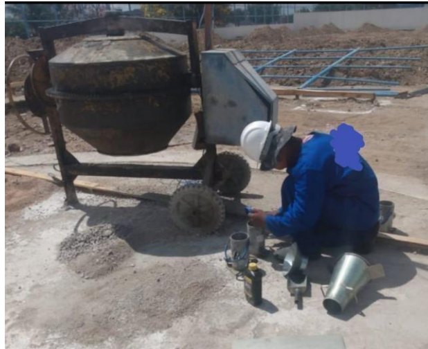
Figura 8- Limpeza dos equipamentos e processo de aplicação do óleo queimado nos moldes.
