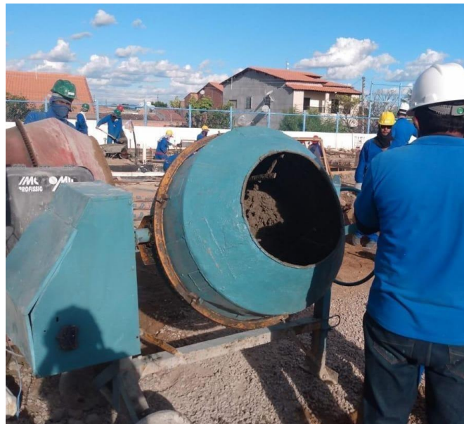
Figura 10- concreto sendo rodado na betoneira.
