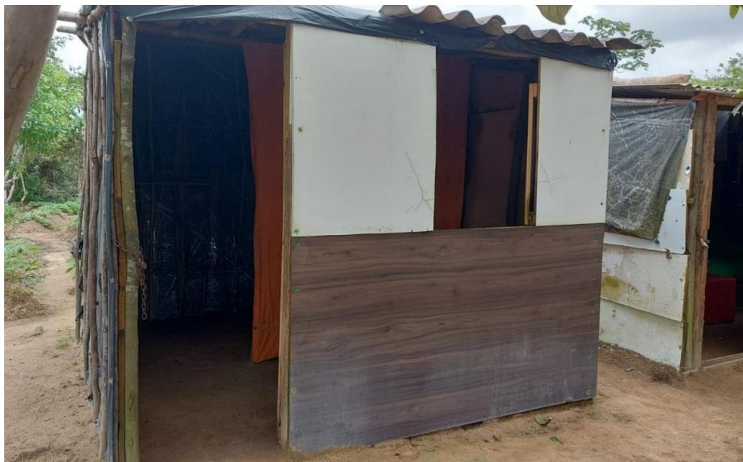
Figura 32 - Barracos em madeira.
