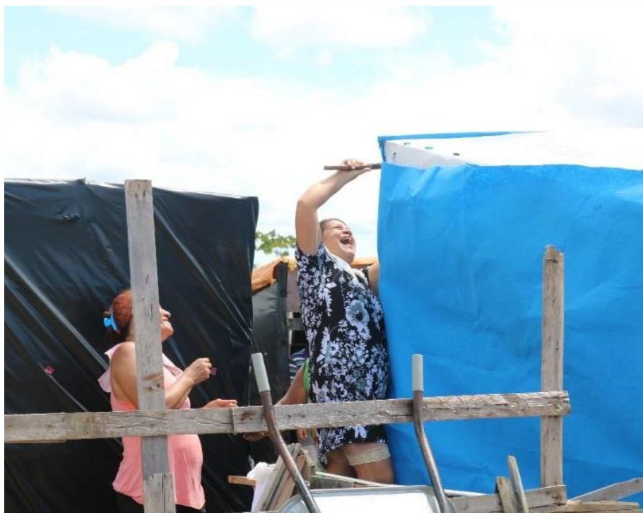
Figura 8 - Processo de construção de barracos na Ocupação Dandara.
