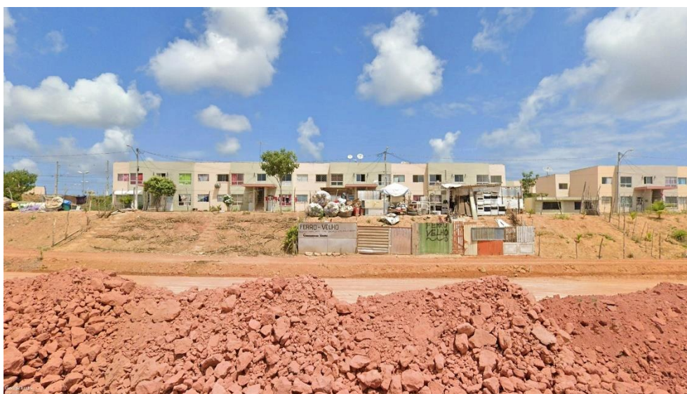
Figura 52 - Conjunto Morada do Planalto, Maceió, Alagoas.
