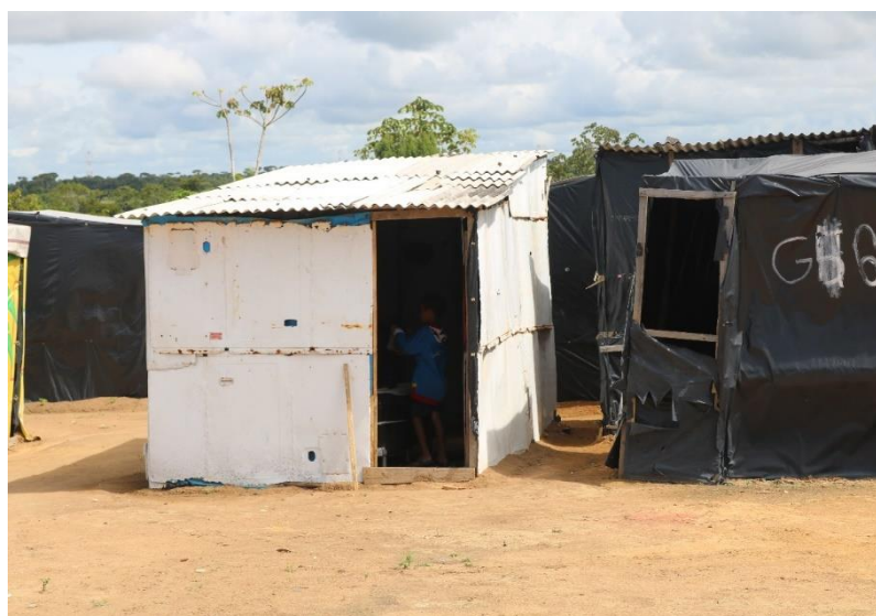
Figura 34 – Barraco em alumínio e telhado de fibrocimento.
