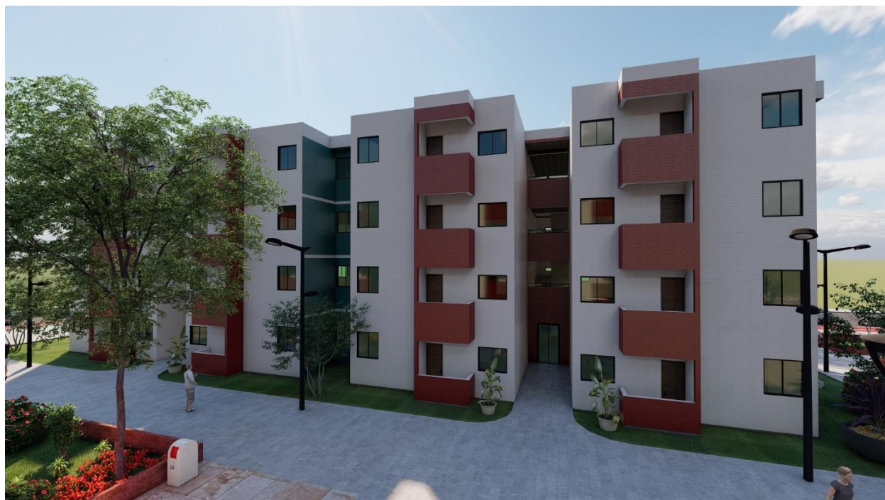
Figura 64 - Fachada principal do edifício multifamiliar da Ocupação Dandara.
