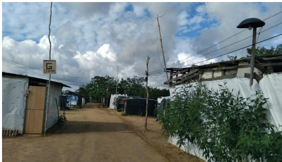
Figura 39 - Rede improvisada de energia elétrica e de iluminação pública da Ocupação Dandara.
