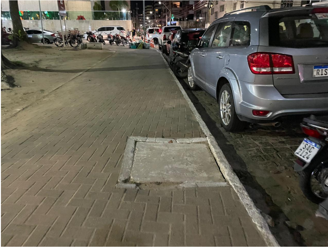
Figura 27 – Observa-se a ausência de piso direcional e de alerta nos obstáculos de acesso à manutenções pluviais e postes informativos.
