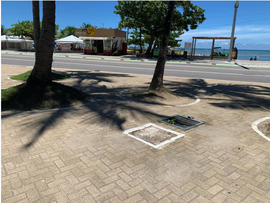
Figura 30 - Observa-se a ausência de pisos direcionais e de alerta
