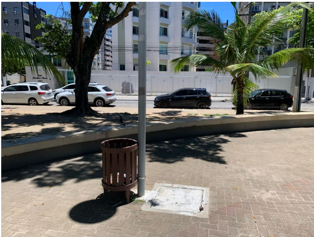
Figura 29 – Observa-se a barreira informativa na lixeira e a ausência de pisos direcionais e de alerta.
