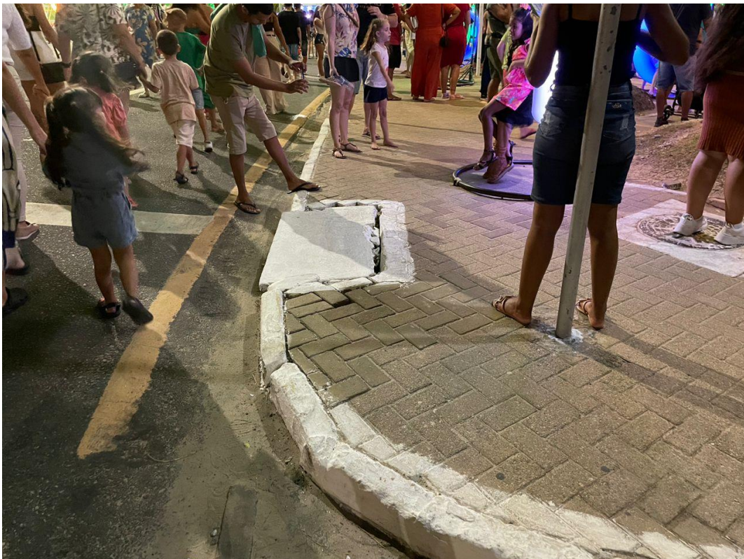
Figura 27 – Observa-se a ausência de piso direcional e de alerta nos obstáculos de acesso à manutenções pluviais e postes informativos.
