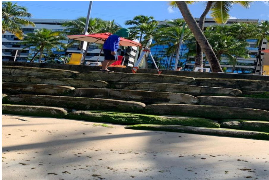
Figura 17: Muro de contenção localizado na Praia de Pajuçara.
