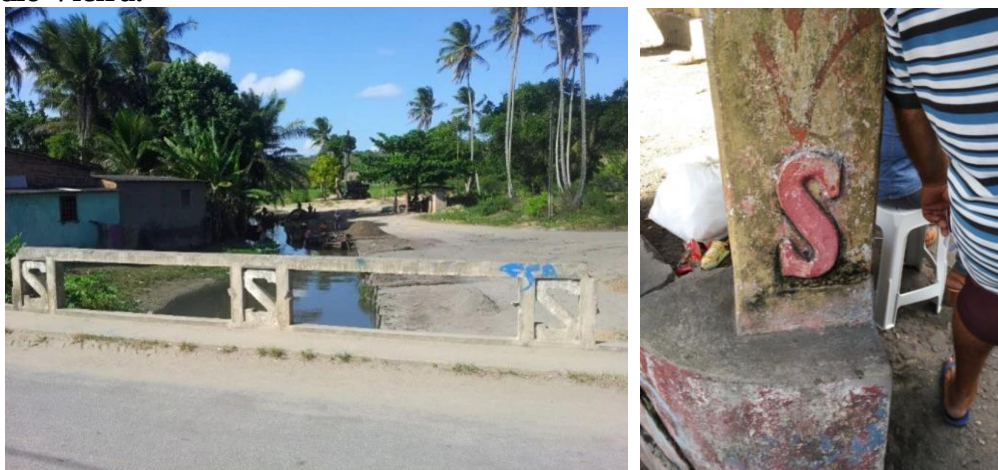
Figuras 29 e 30 - Remanescentes de ponte no bairro Rio Novo; Balaústre na Praça Antídio Vieira.
