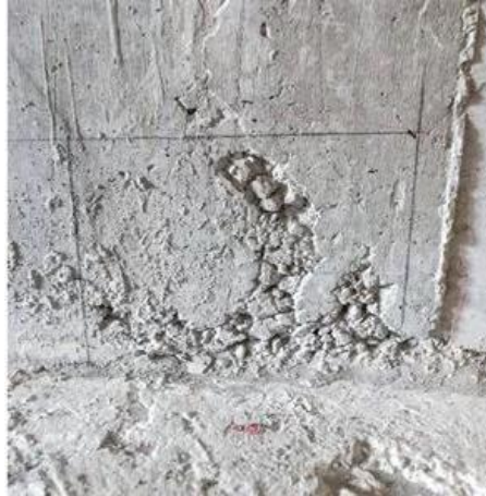
Figura 7 – Concreto desagregado.
