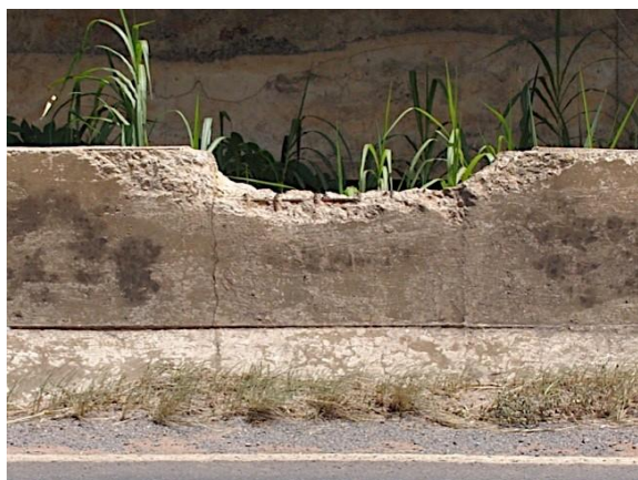
Figura 7: deslocamento ( F_i = 4 )
