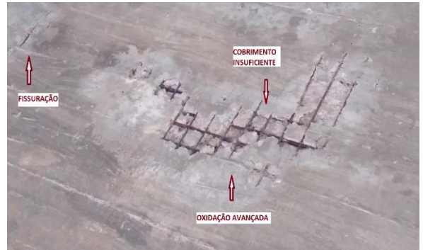
Figura A. 6 – Desagregação, corrosão das armaduras
