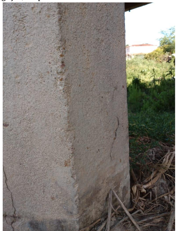
Figura A. 7 – Desagregação, deslocamento.
