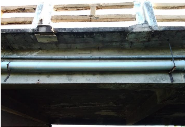
Figura A. 6 – Desagregação, corrosão das armaduras
