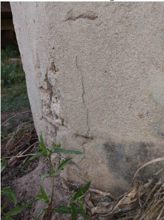
Figura A. 7 – Desagregação, deslocamento.
