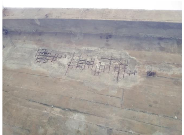
Figura A. 6 – Desagregação, corrosão das armaduras
