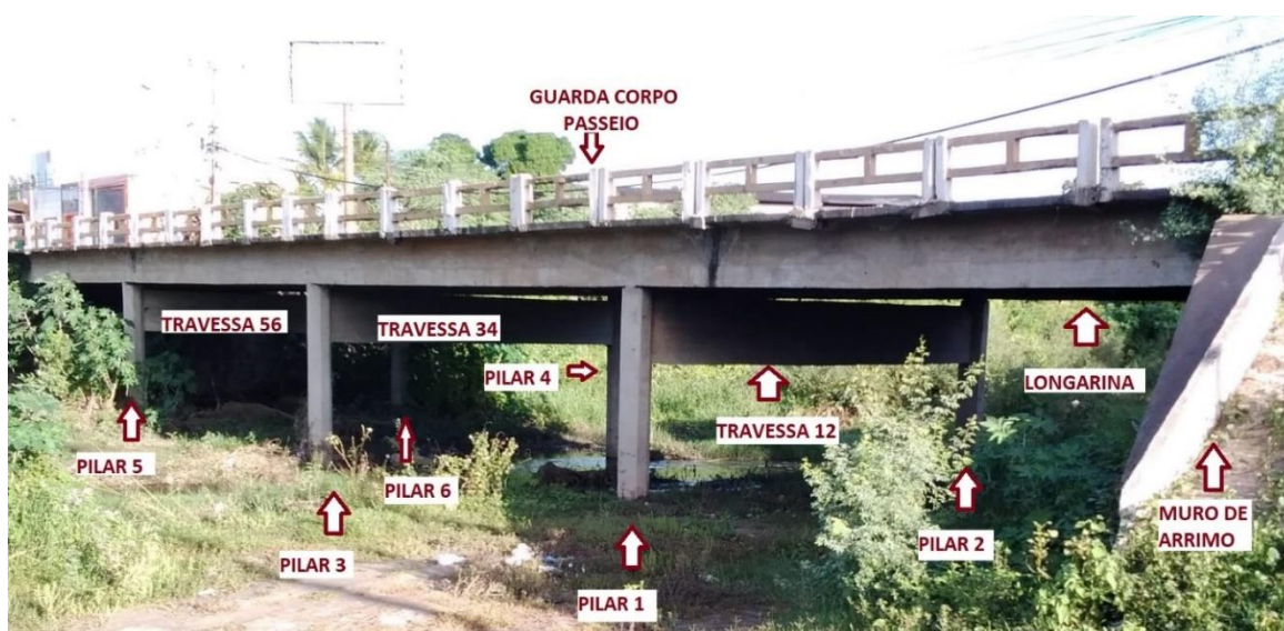
Figura 15 – Divisão do sistema estrutural.
