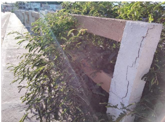
Figura 23 – Guarda-corpo fissurado.
