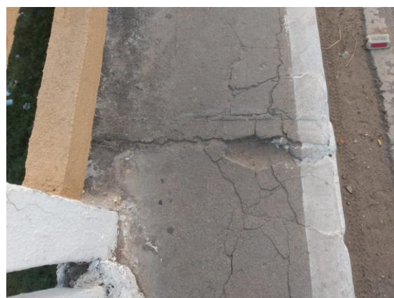
Figura 22 – Passeio esmagado.
