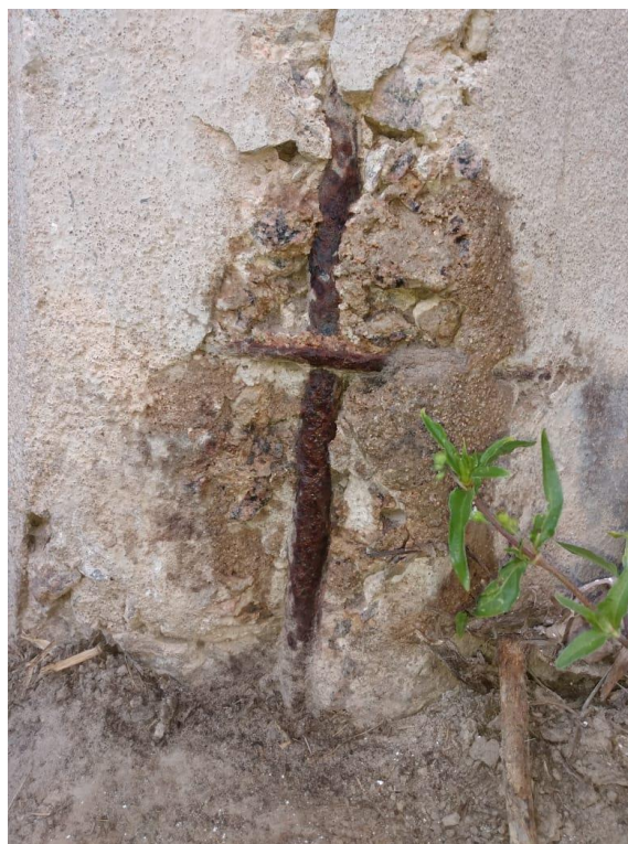
Figura 18 – Pilar carbonatado.
