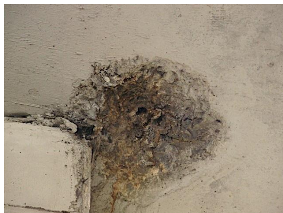
Figura 4: desagregação ( F_i = 2 )
