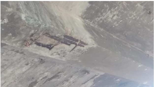
Figura A. 6 – Desagregação, corrosão das armaduras
