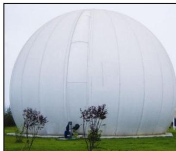
Instalado sobre uma base de concreto e é constituído por uma membrana exterior, uma interior, e outra inferior. Preço: R\$ 70.000,00 (Mercado Livre, 2016)
