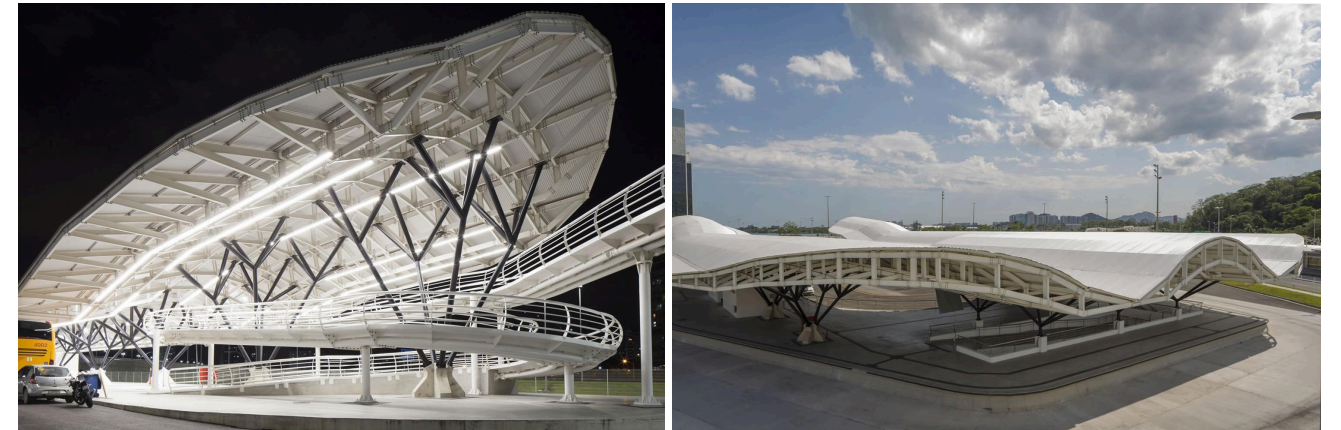
Figuras 74 e 75: Sistema de pilar árvore no Terminal Parque Olímpico - RJ.
