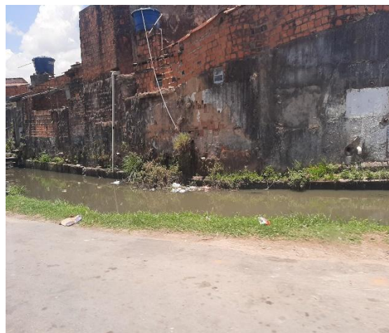
FIGURA 10: Esgoto a céu aberto
