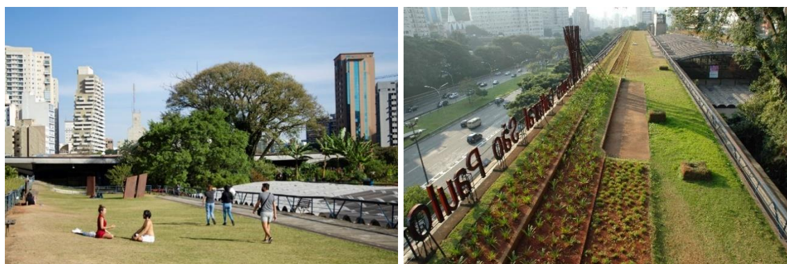
Figuras 29 e 30: Telhado Verde do Centro Cultural São Paulo.
