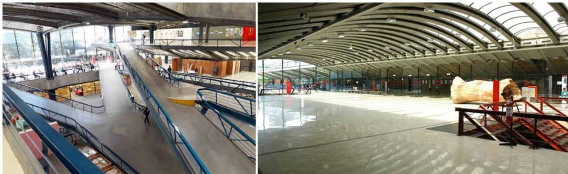
Figuras 31 e 32: Rampas de Acesso; Abertura para Iluminação na Coberta do Centro Cultural São Paulo.
