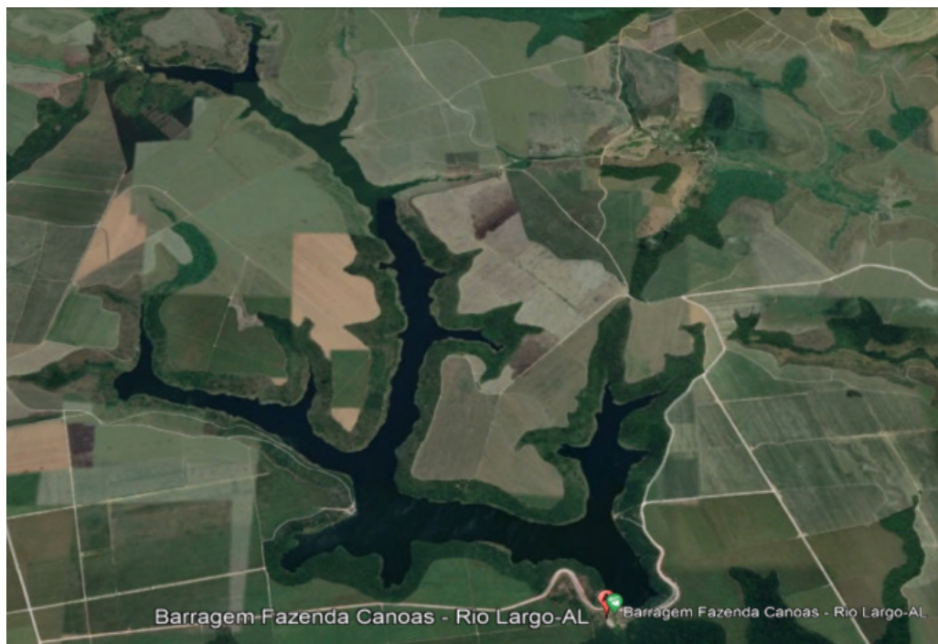
Figura 5 - Barragem instalada ao curso da Bacia Hidrográfica do Pratagy
