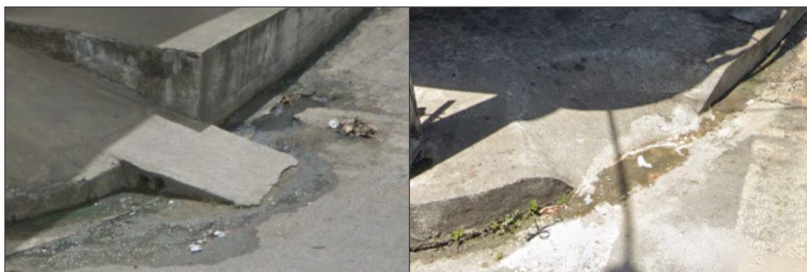
Figura 30 - Fotografias de exemplos de rampas da área 1
