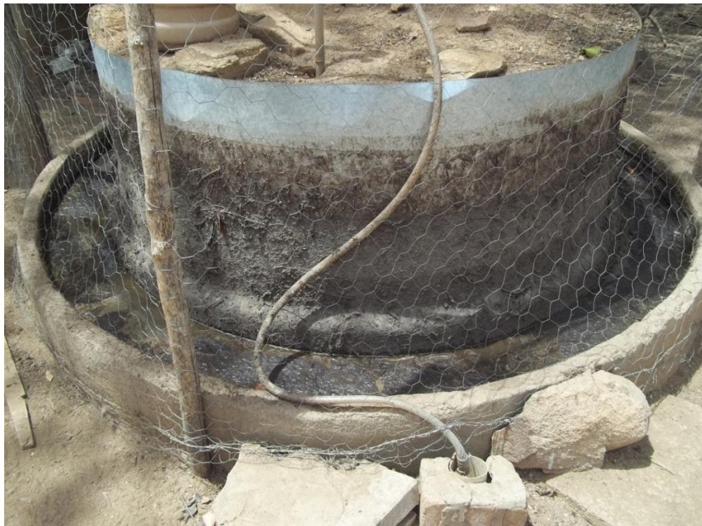
Figura 33: Mangueira utilizada para levar o biogás para dentro da residência para ser utilizado como gás de cozinha
