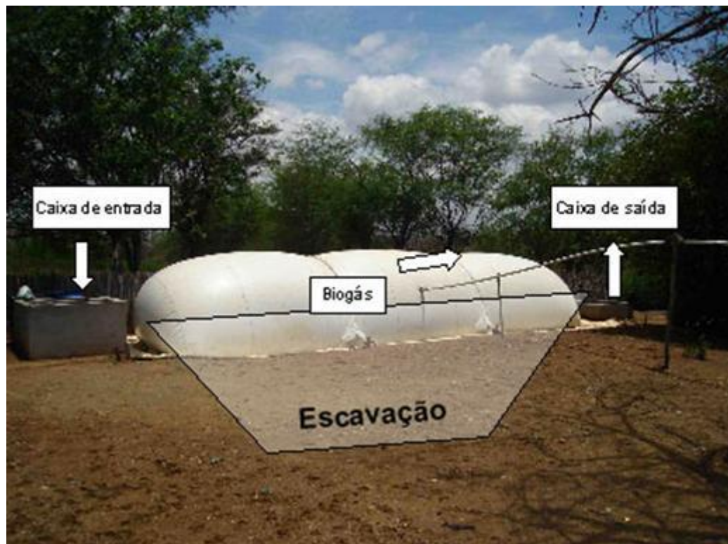
Figura 29: Biodigestor Modelo Canadense
