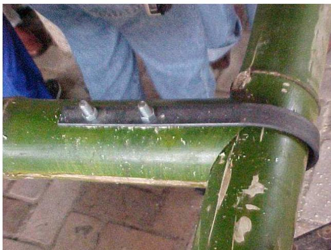
**Ilustração 40: Fixação entre varas de bambu.**
