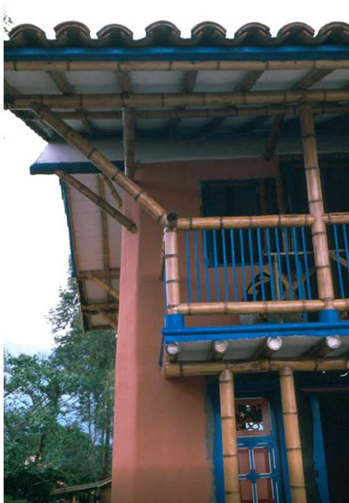
**Ilustração 69: Bambu usado na estrutura de uma varanda – vigas, colunas, guarda-corpo e telhado.**
