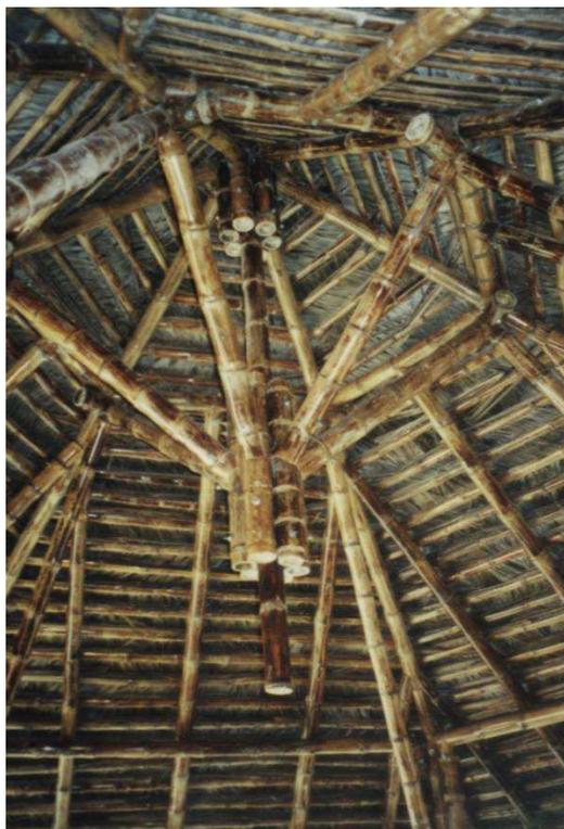
**Ilustração 72: Bambu usado na estrutura de um telhado.**
