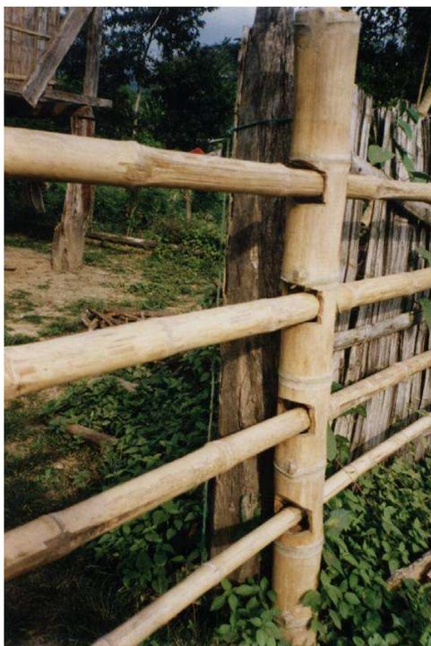
**Ilustração 70: Bambu usado na construção de uma cerca.**
