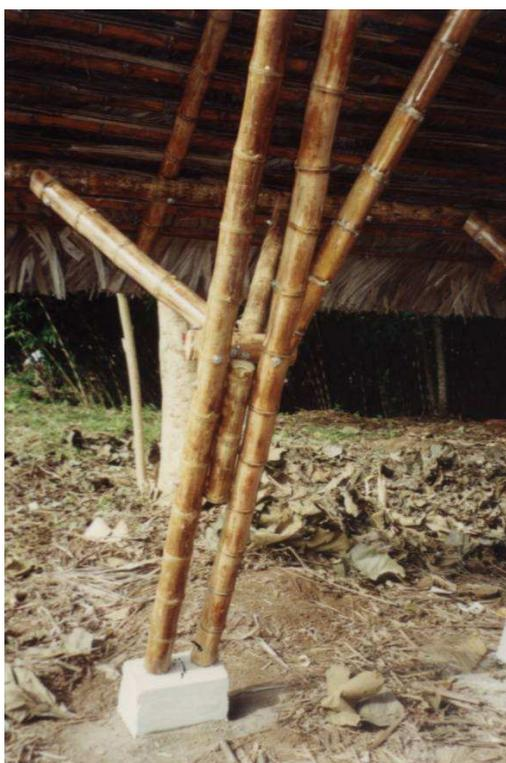
**Ilustração 39: Fixação de coluna ao solo por base de concreto.**
