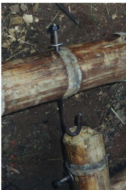
**Ilustração 41: Fixação entre varas de bambu concretadas.**
