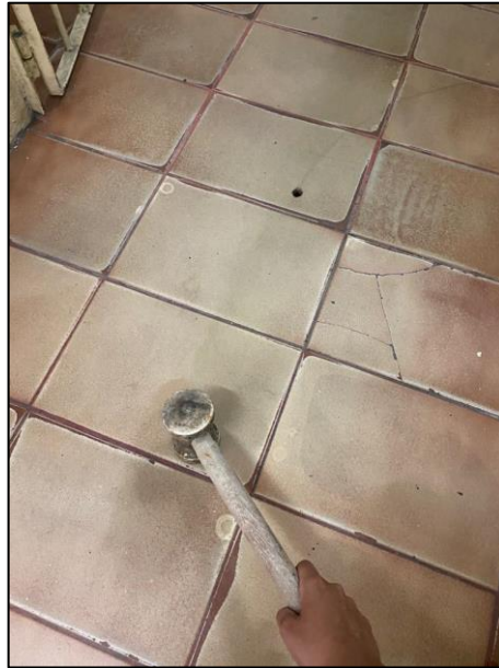
Figura 37 - Ensaio de percussão em piso cerâmico
