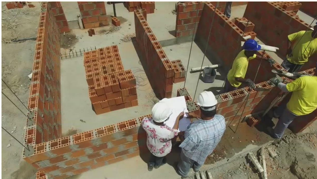
Figura 2 - Alvenaria coordenada modularmente na UFAL
