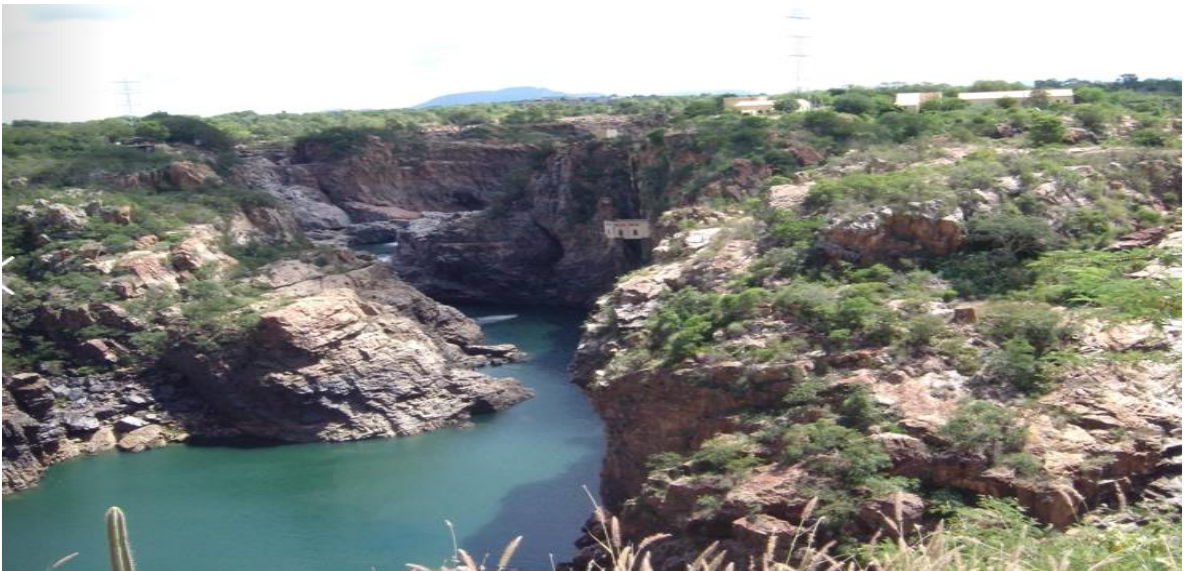
Figura 12: Vista parcial da usina hidrelétrica de Angiquinho
