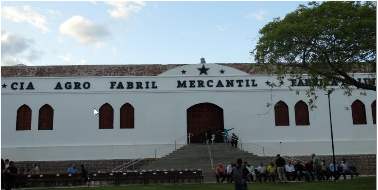
Figura 18: Novo visual do antigo prédio
