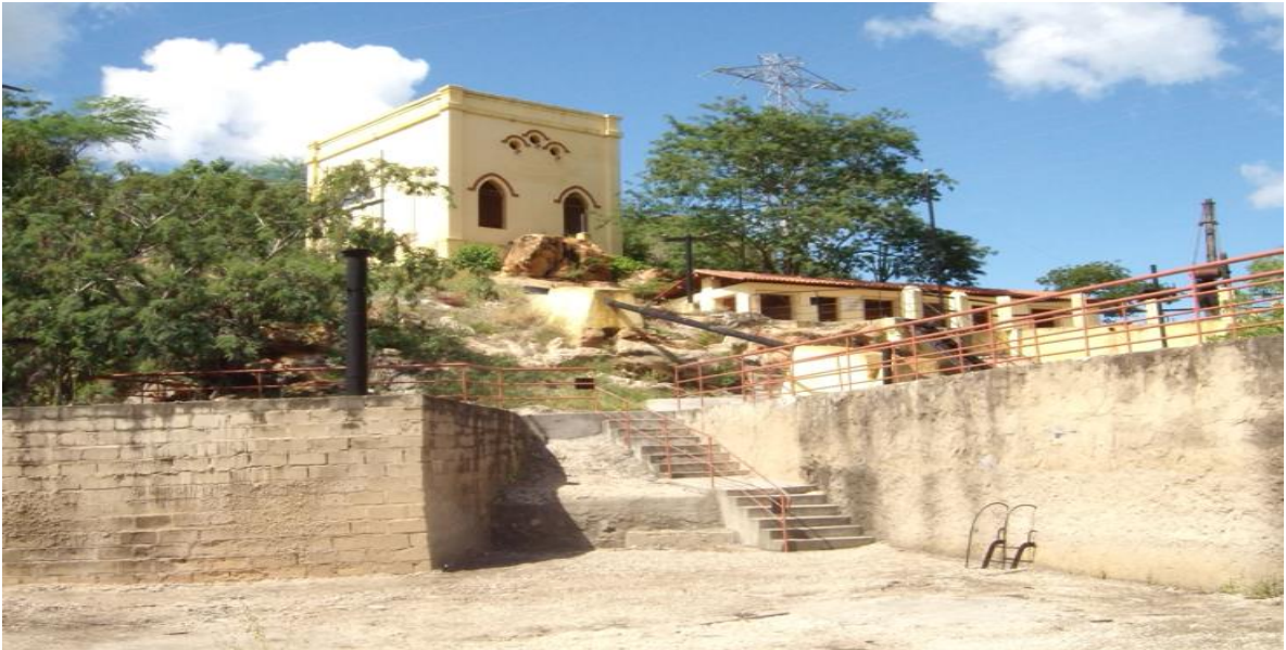
Figura 13: Parte da usina hidrelétrica de Angiquinho
