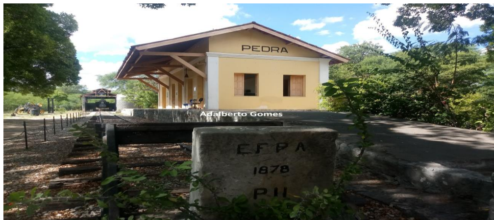
Figura 06: Estação da Pedra
